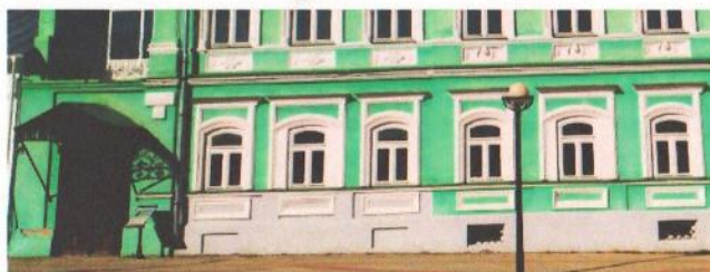
Фрагмент главного фасада по ул. Большая Покровская до установки информационной надписи
