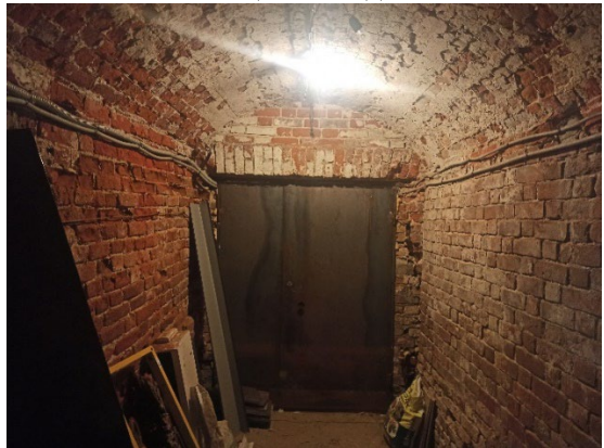
Кирпичные цилиндрический свод в помещении подвала
