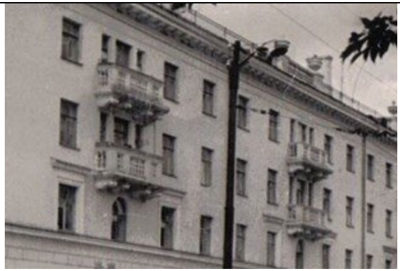
Балкон с кронштейнами и балюстрадным ограждением
