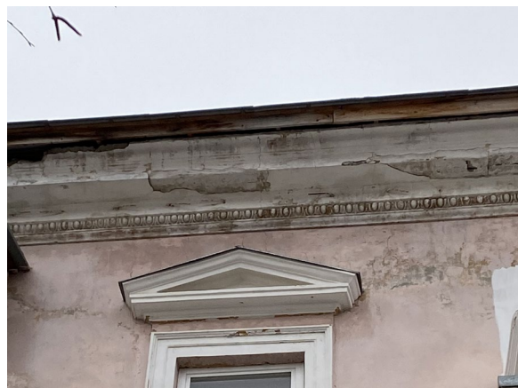
Профильный карниз, украшенный декоративным орнаментальным элементом (овы)
