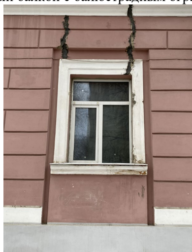
Оконный проем первого этажа углублённое в нишу
