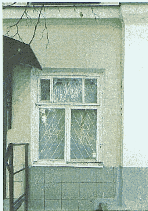
Историческая расстекловка окон первого этажа
