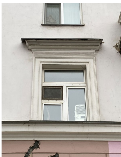
Оконный проем первого этажа углублённое в нишу
