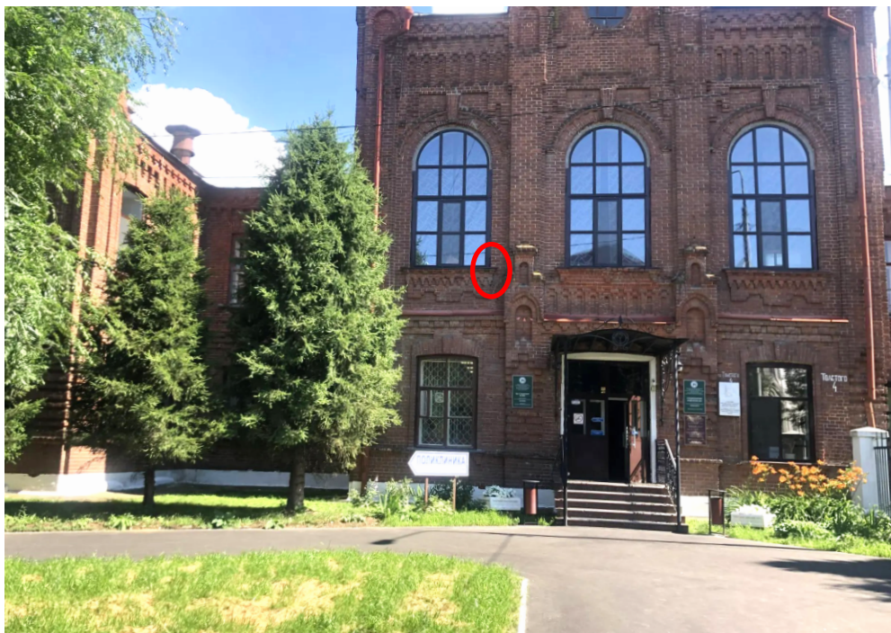
1. Вид на объект до установки информационной надписи
