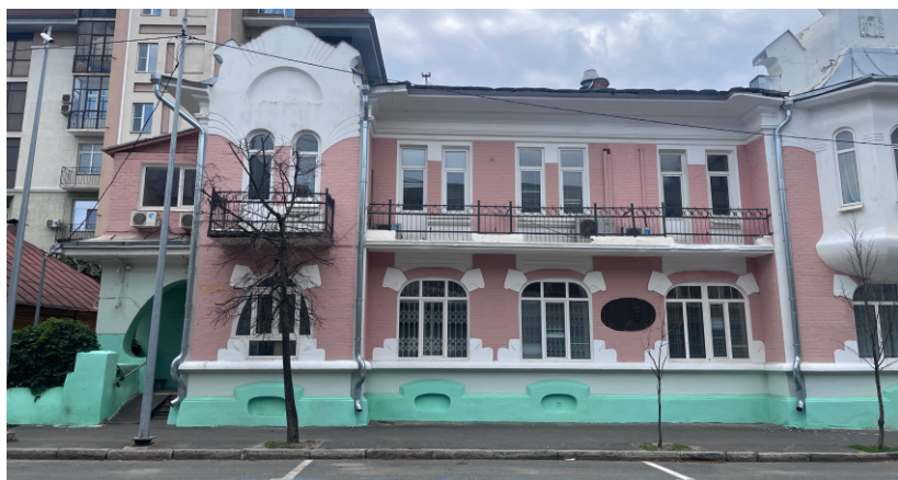
2. Вид на объект до установки информационной надписи
