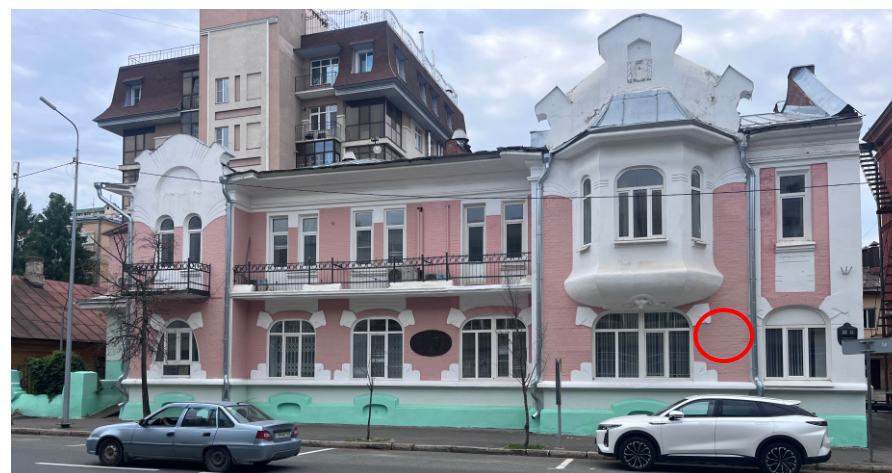
1. Вид на объект до установки информационной надписи
