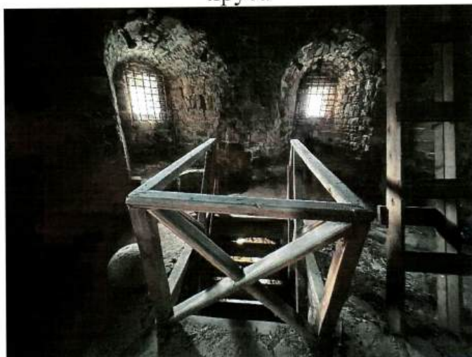
Рис. 21. Перекрытие и лестничный марш второго яруса
