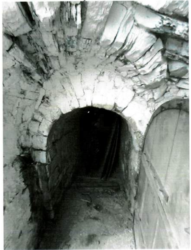
Рис. 11. Дверной арочный проем на втором ярусе.
