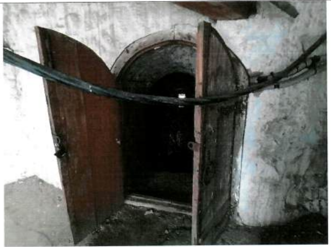
Рис. 10. Дверной арочный проем на первом ярусе. Столярное заполнение проема.
