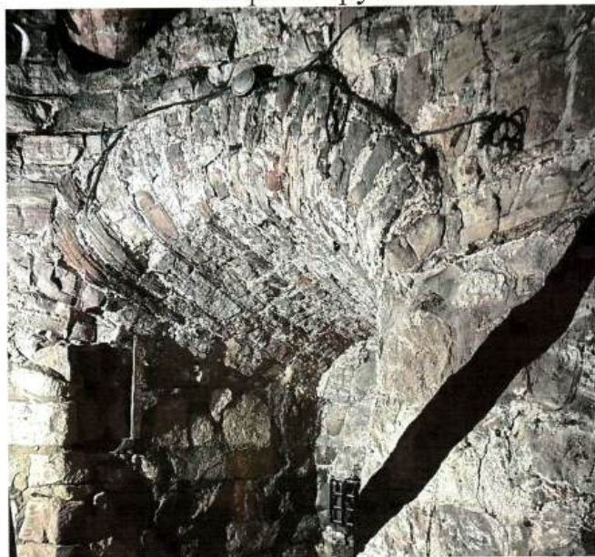
Рис. 22. Каменная перемычка арочных проемов бойниц. Второй ярус.
