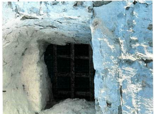
Рис. 13. Заполнение проемов бойниц первого и третьего яруса – кованые решетки.
