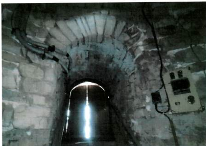
Рис. 24. Каменная перемычка дверного арочного проема на втором ярусе.
