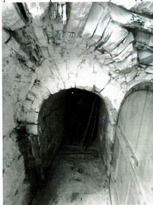
Рис. 24. Каменная перемычка дверного арочного проема на втором ярусе. Вид снаружи.
