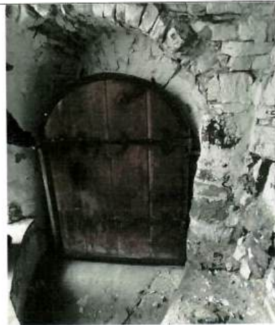
Рис. 12. Столярное заполнение дверного арочного проема на втором ярусе.
