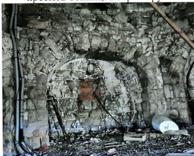
Рис. 22. Каменная перемычка арочных проемов бойниц. Второй ярус.
