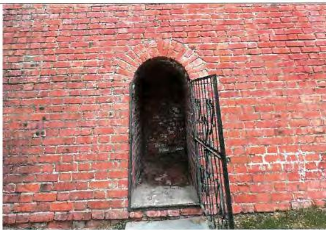
Рис. 22. Арочный свод дверного проема
