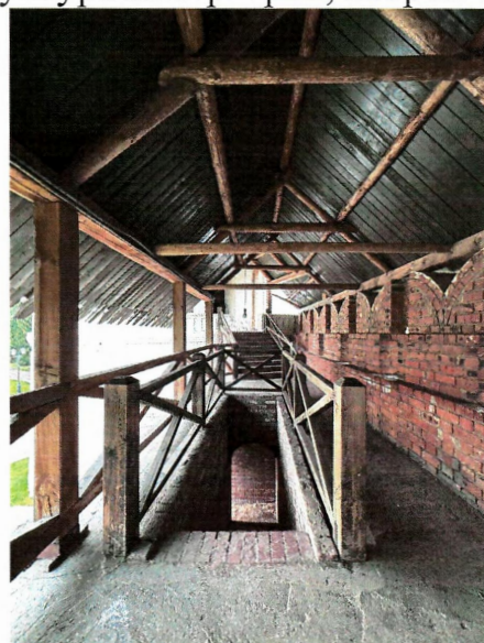
Рис. 17. Вход с лестницей в теле забутовки стены (второй этаж)
