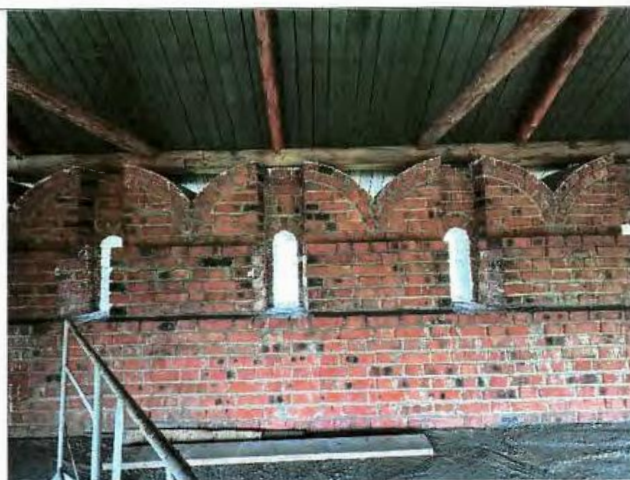
Рис. 6. Кирпичные зубцы и арочные бойницы
