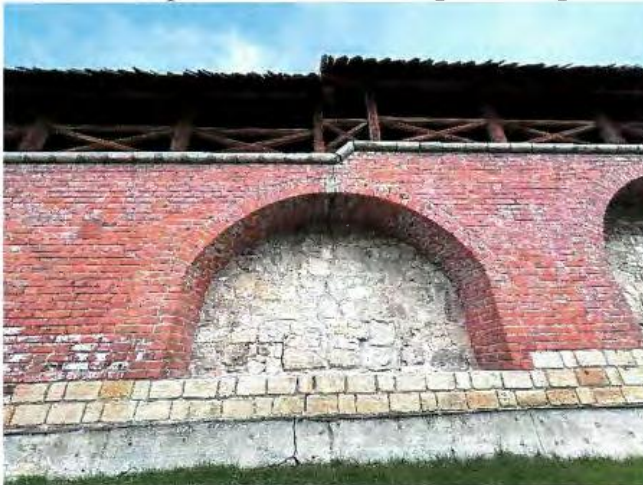
Рис. 23. Перемычки и своды печур. Фрагмент
