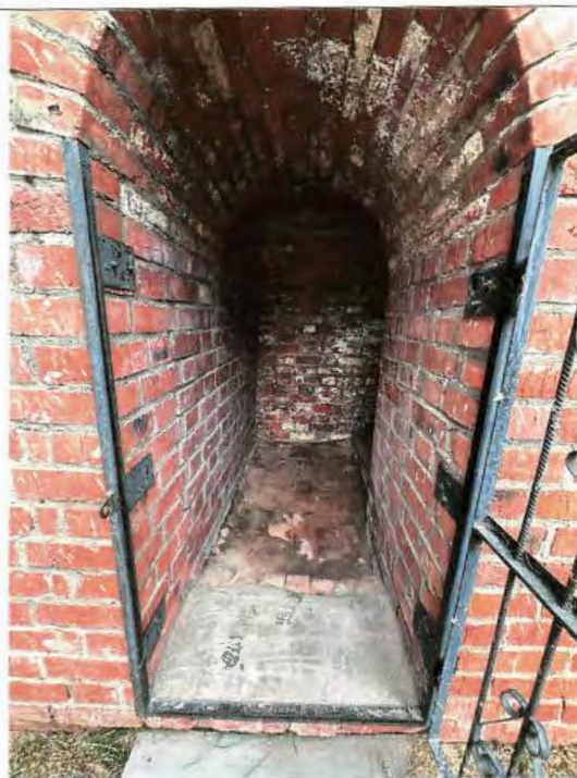
Рис. 19. Дверной арочный проем первого этажа
