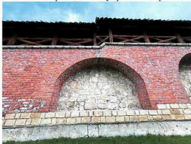
Рис. 14. Печуры и цоколь, выложенные камнем
