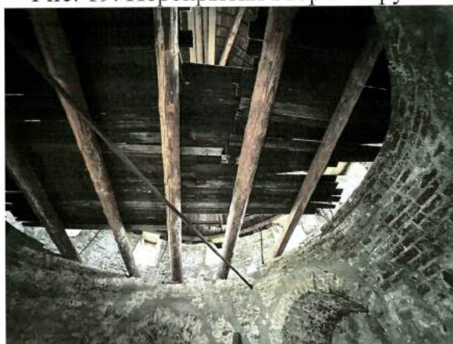
Рис. 20. Перекрытия третьего яруса
