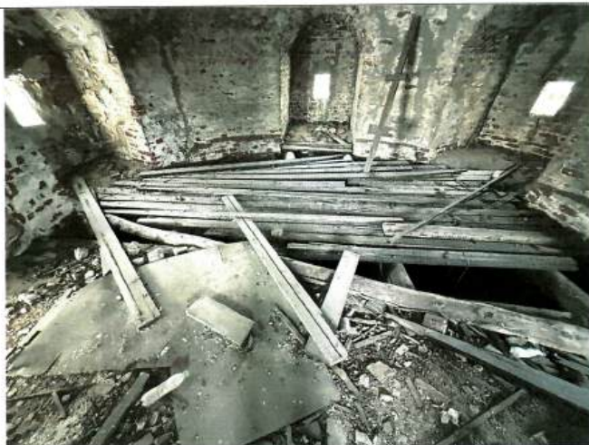
Рис. 19. Перекрытия второго яруса
