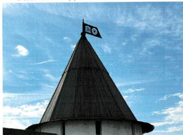
Рис. 11. Шатровая тесовая кровля с полицами, металлический прапор.
