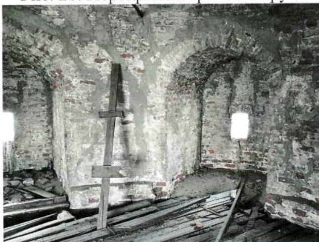
Рис. 21. Кирпичные перемычки арочных проемов бойниц. Третий ярус
