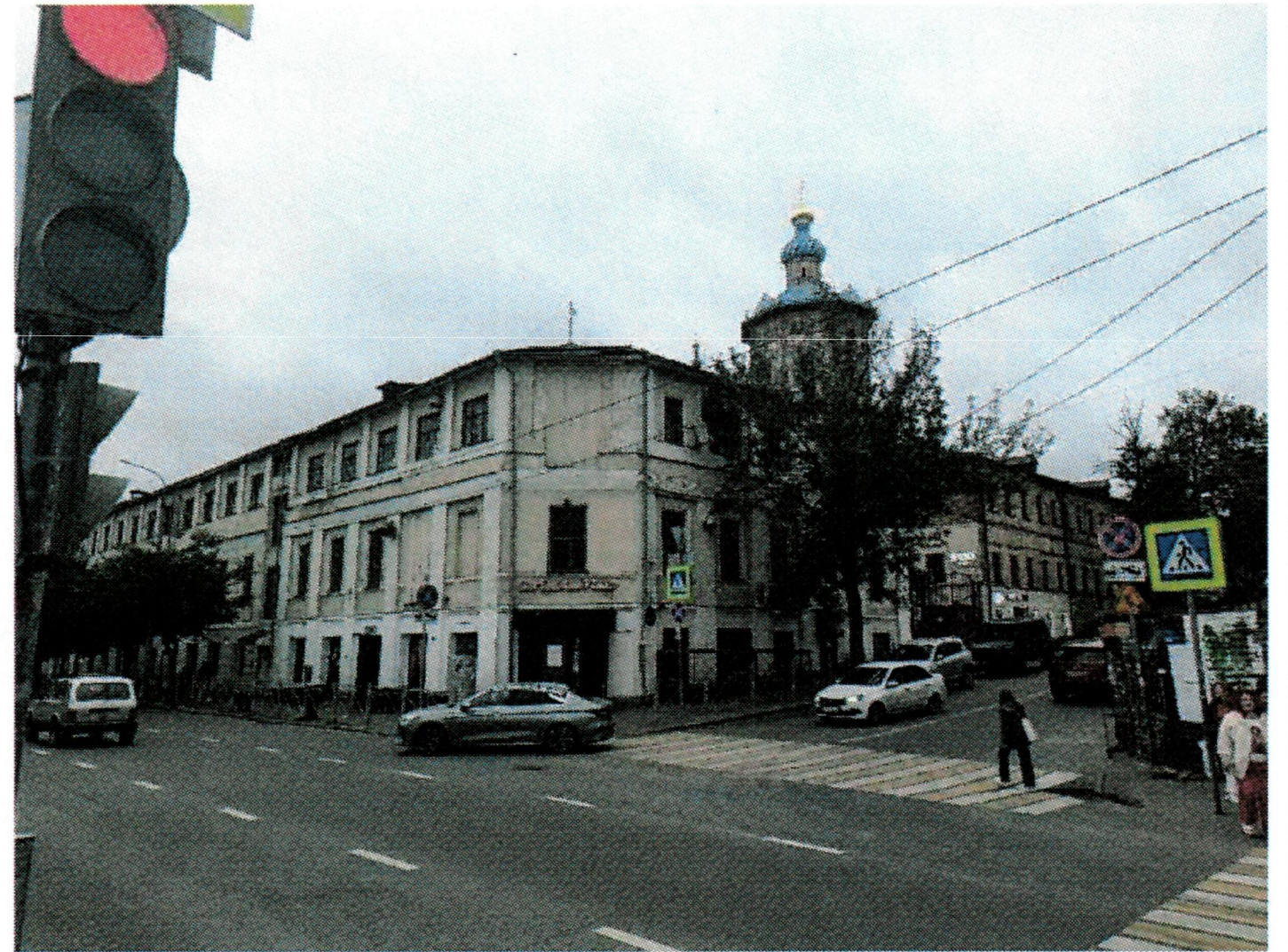
Рис. 13. Вид на фасад по ул. Чернышевского
