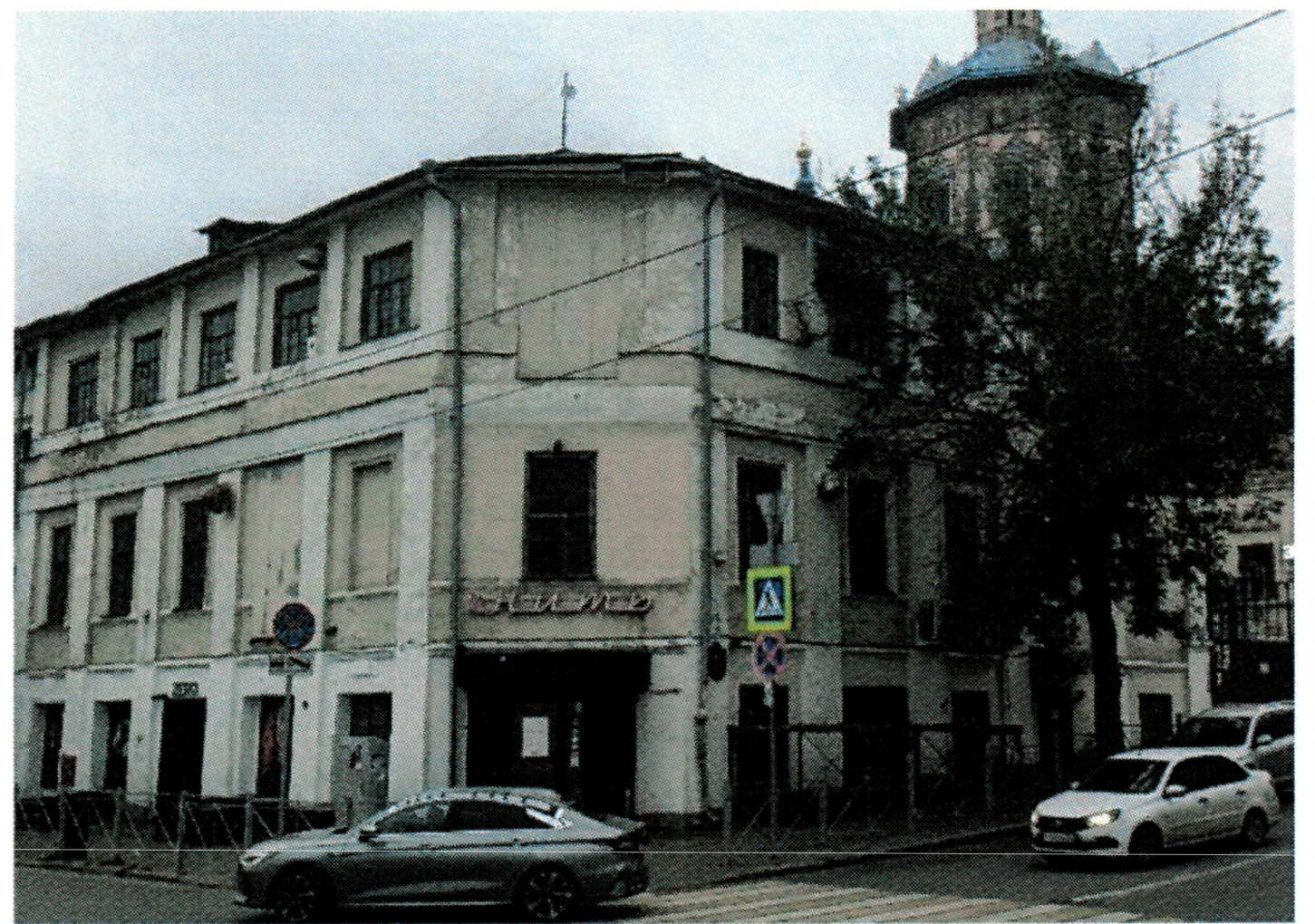
Рис. 14. Оконные проемы 1 этажа
