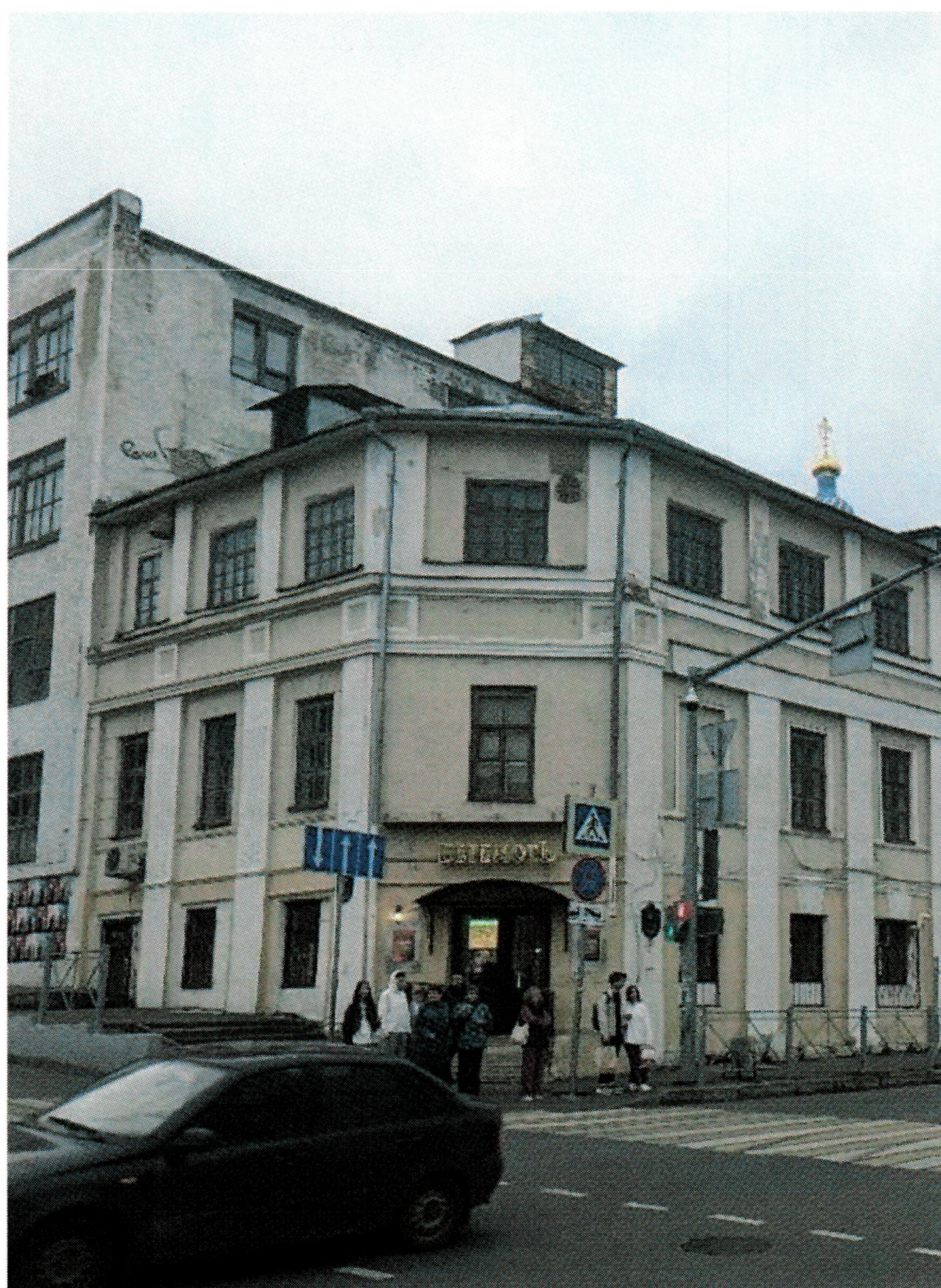
Рис. 11. Фрагмент фасада по ул. Чернышевского
