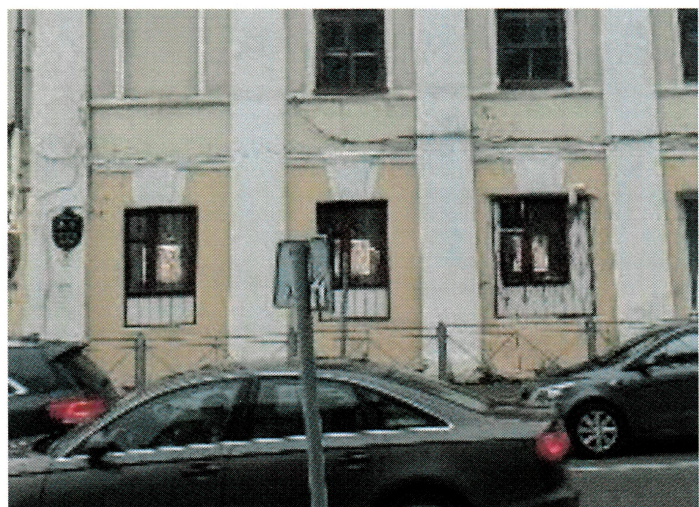
Рис. 10. Оконные проемы первого этажа
