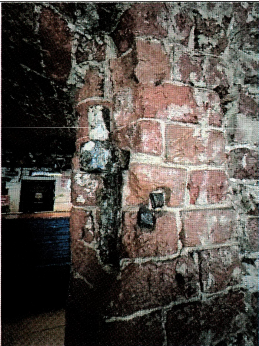
Рис. 26. Металлические кулачки в проемах первого этажа
