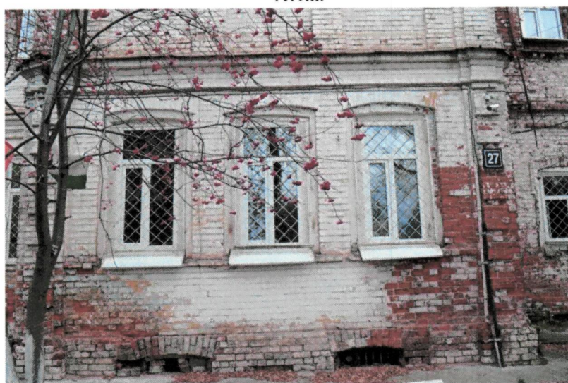
Оконные проемы 1 этажа
