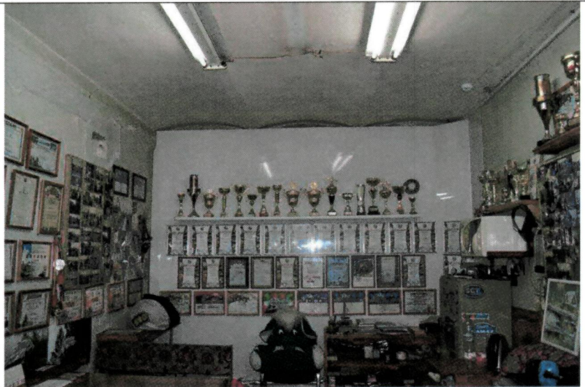
Сводчатое перекрытие подвала
