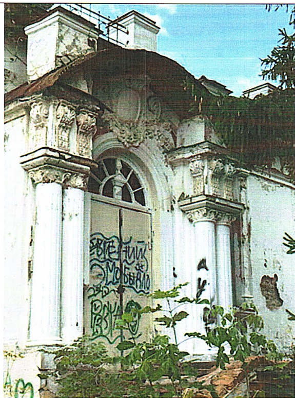
Ордерный портал западного фасада
