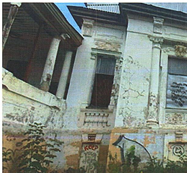
Ордерное окно на подоконном парапете слева от ризалита северного фасада
