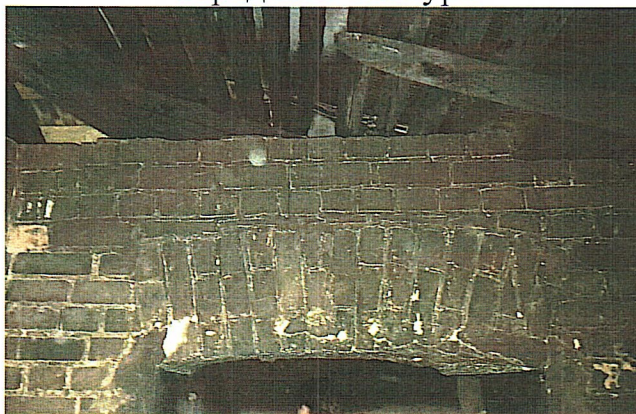
Кирпичные перемычки проемов
