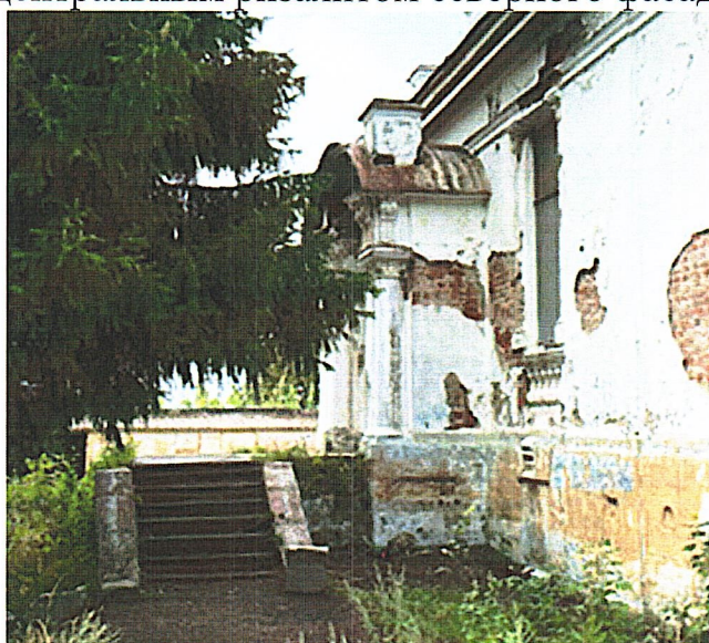
Крыша над парадным порталом западного фасада
