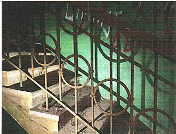
Кованое ограждение служебной лестницы
