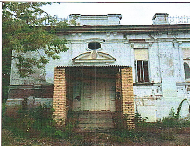
Дверной портал восточного фасада
