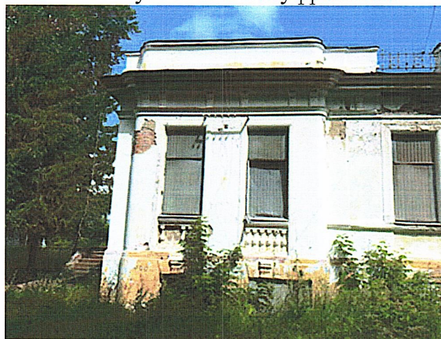
Левый ризалит южного фасада
