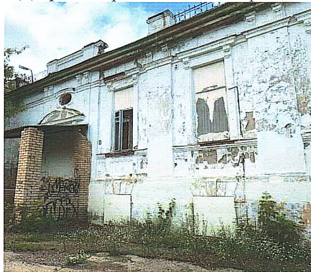
Окна восточного фасада под сандриками на кронштейнах, простеночные пилястры, окна цокольного этажа
