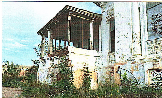
Колонны на глухом парапете северо-восточной террасы
