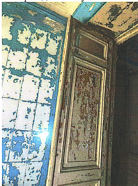
Плитка в отделке зеркала печи
