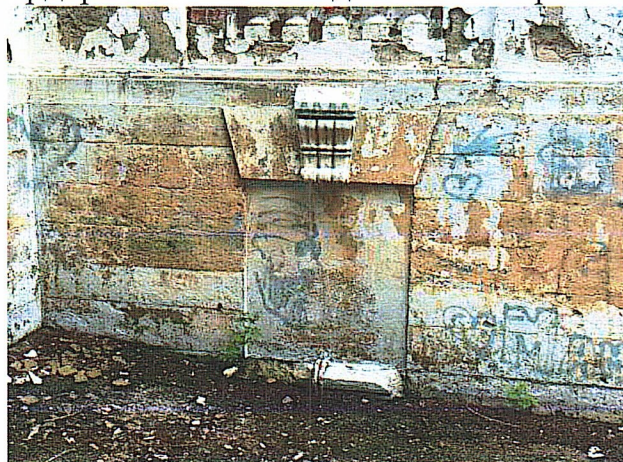
Окна цокольного этажа (западный фасад)
