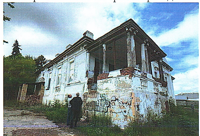
Северо-восточный угол объекта
