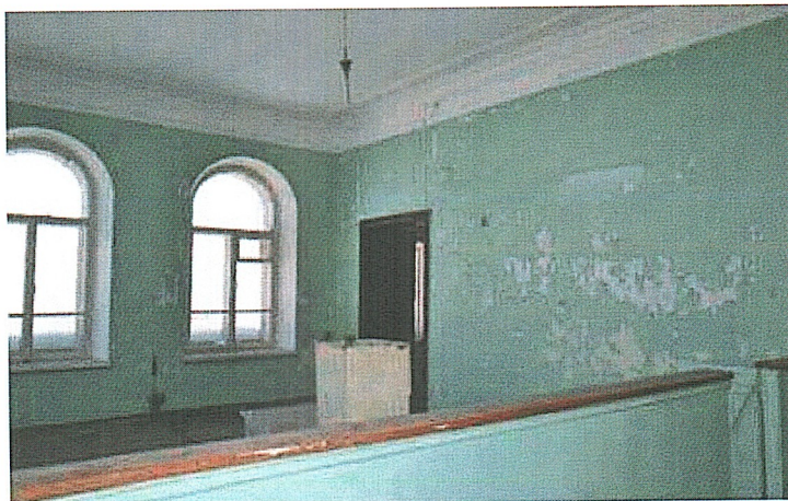
Рис 26. Потолочные тяги и арочные оконные проемы
