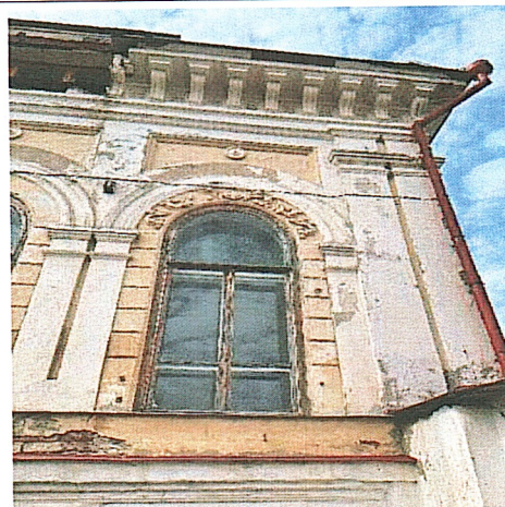
Рис 16. Расстекловка оконных заполнений
