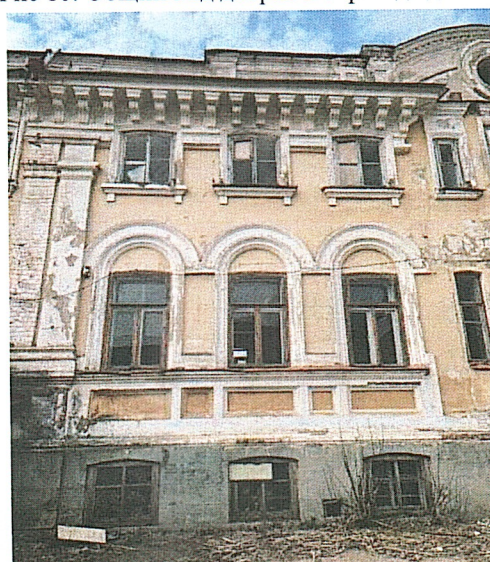
Рис 11. Лепной декор дворового фасада дома
