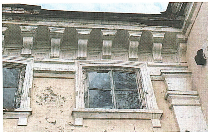
Рис 13. Лепной декор дворового фасада дома
