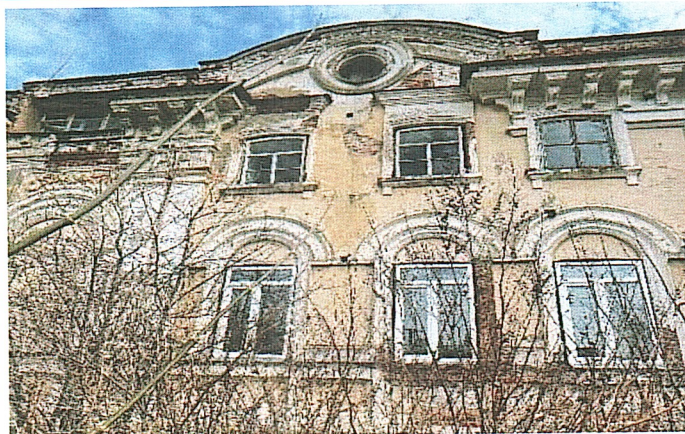
Рис 12. Лепной декор дворового фасада дома
