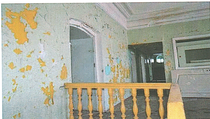
Рис 25. Потолочные тяги и дверной проем второго этажа
