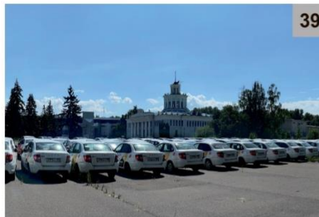
точки визуального восприятия (№№ 38-40) на территории в северной части комплекса
