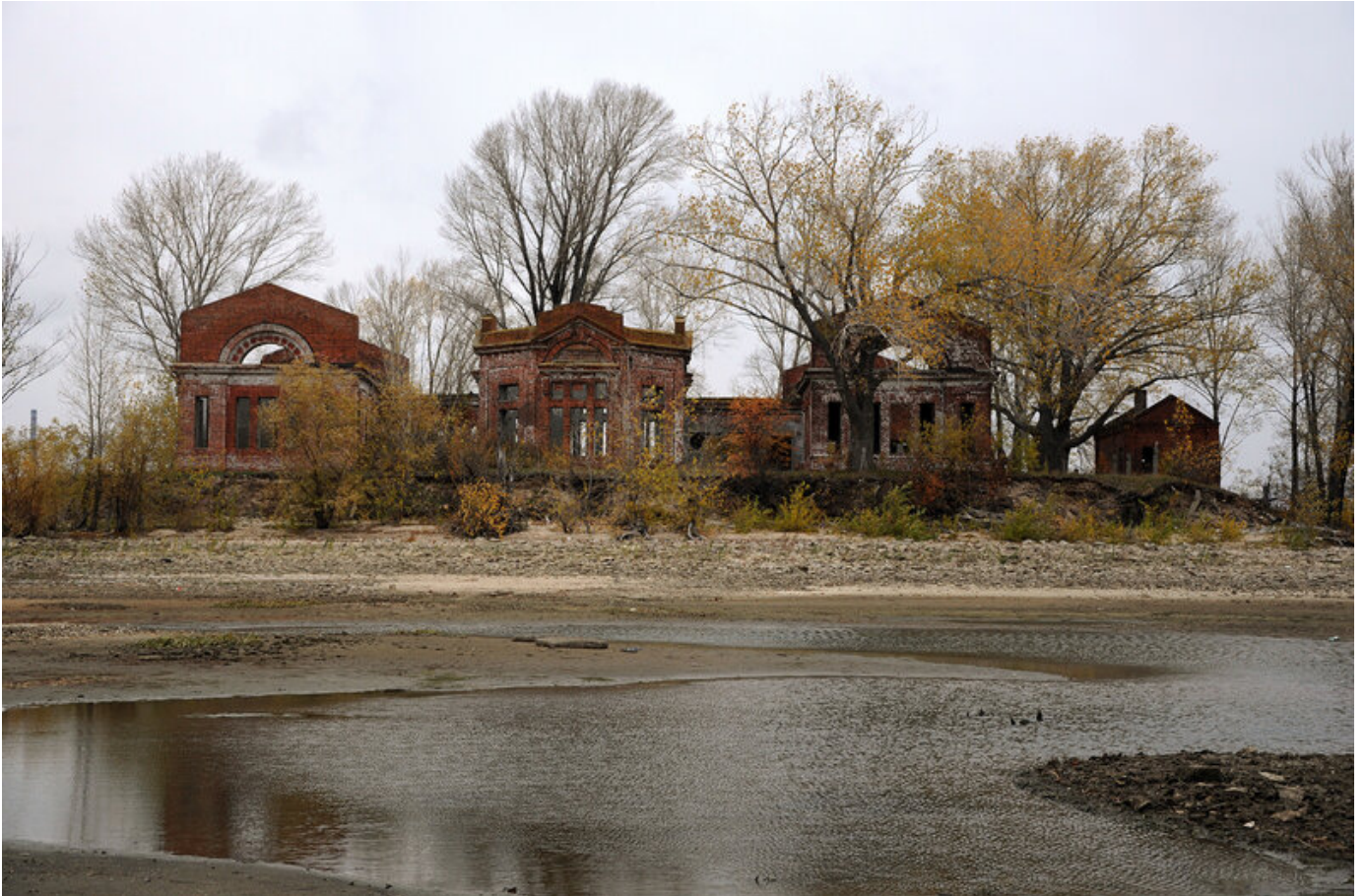
Фото 1. Насосная станция 1-го подъёма (главное здание). Общий вид
