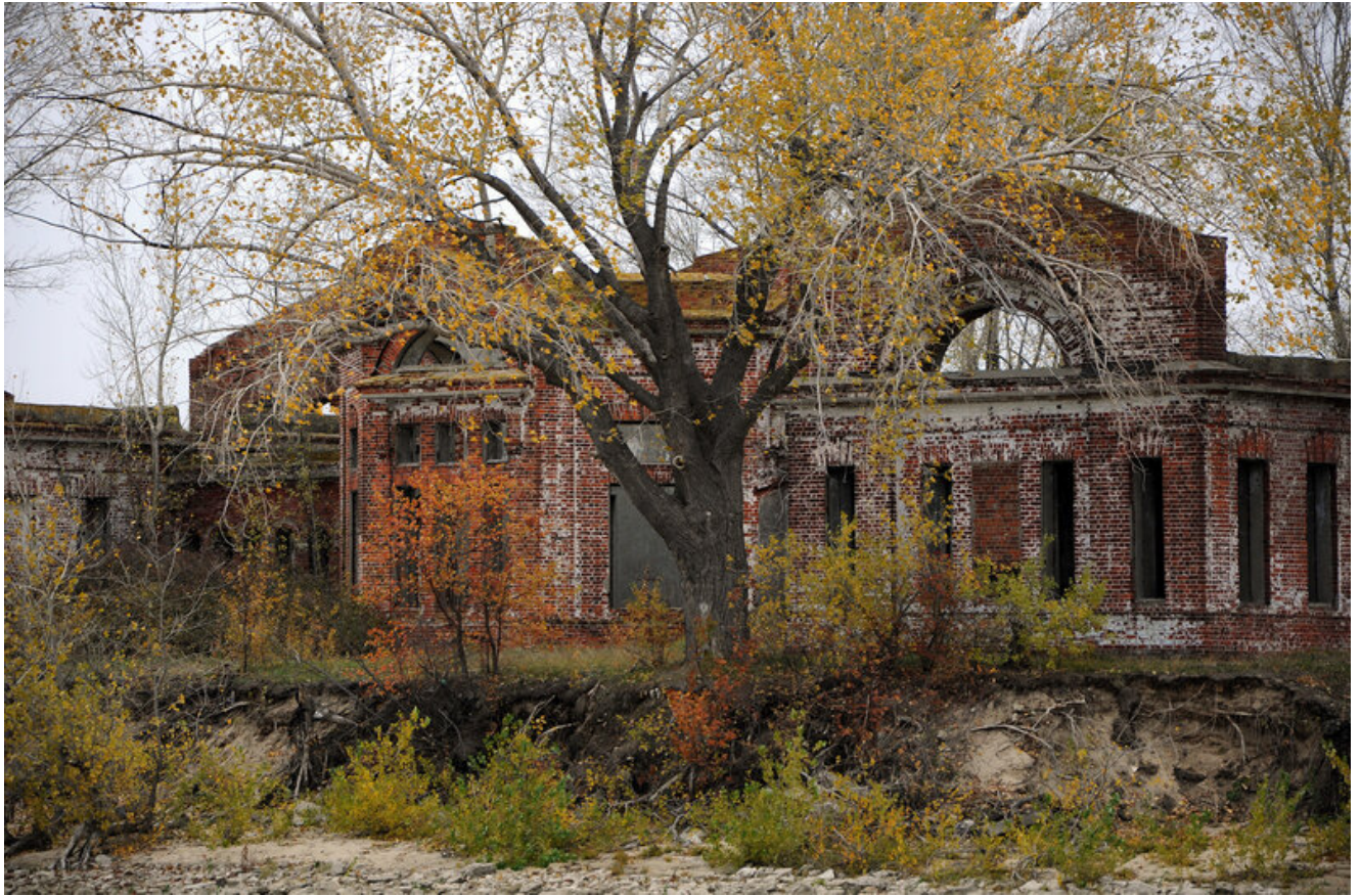
Фото 2. Насосная станция 1-го подъёма (главное здание). Вид с юго-востока
