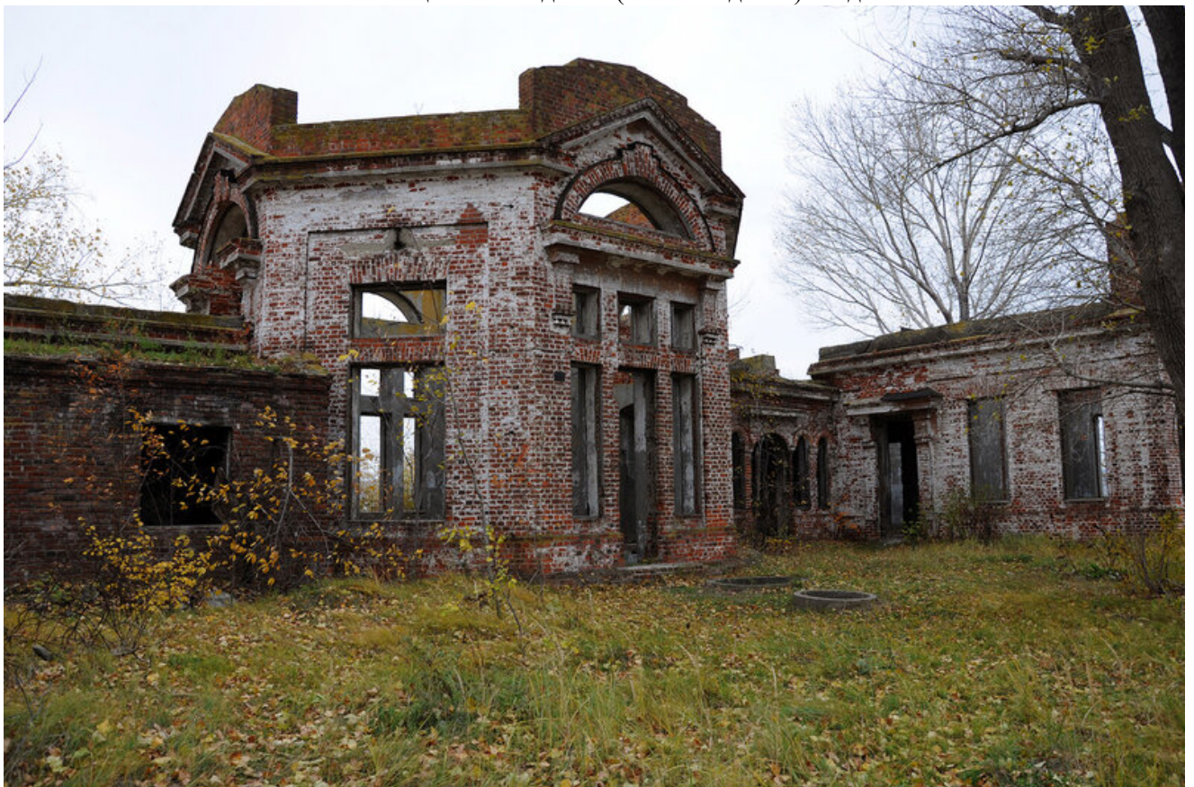
Фото 3. Насосная станция 1-го подъёма (главное здание). Вид с юго-запада
