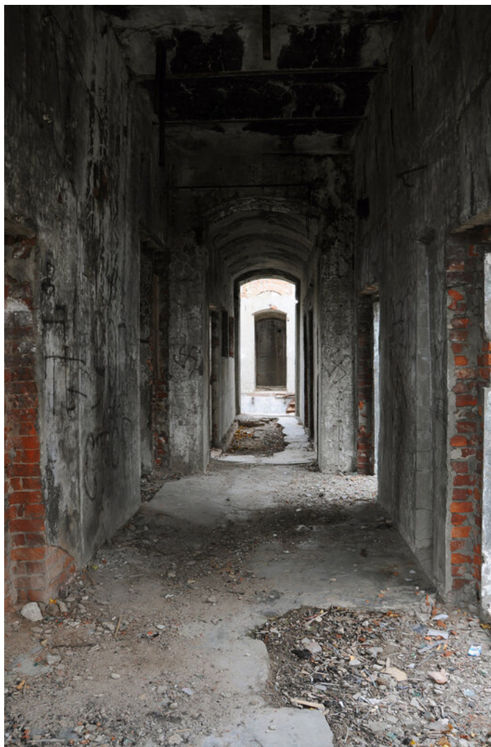
Фото 6. Насосная станция 1-го подъёма (главное здание). Интерьер
