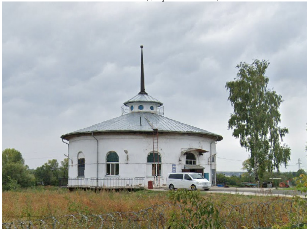
Фото 9. Станция водоподготовки с очистными сооружениями. Вид с востока
