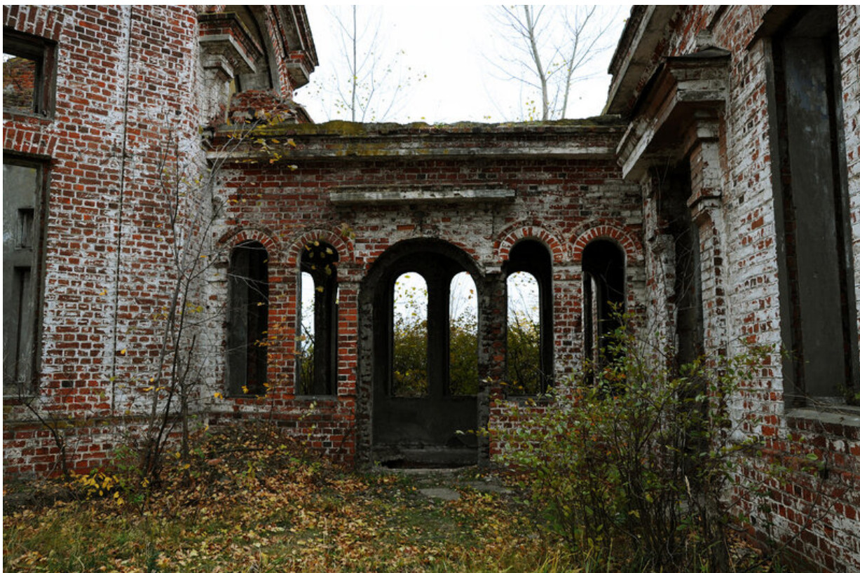
Фото 4. Насосная станция 1-го подъёма (главное здание). Переход
