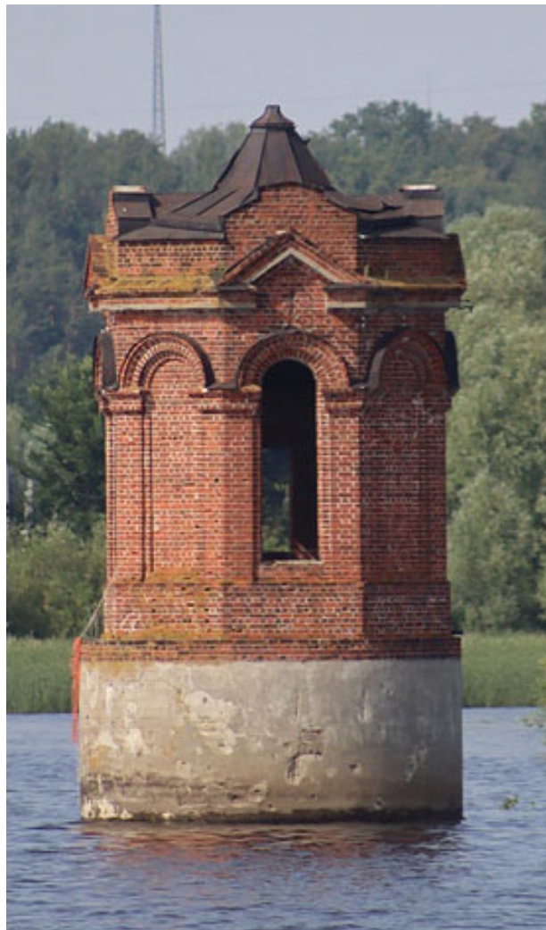
Фото 8. Оголовок водоприемника. Вид с юга
