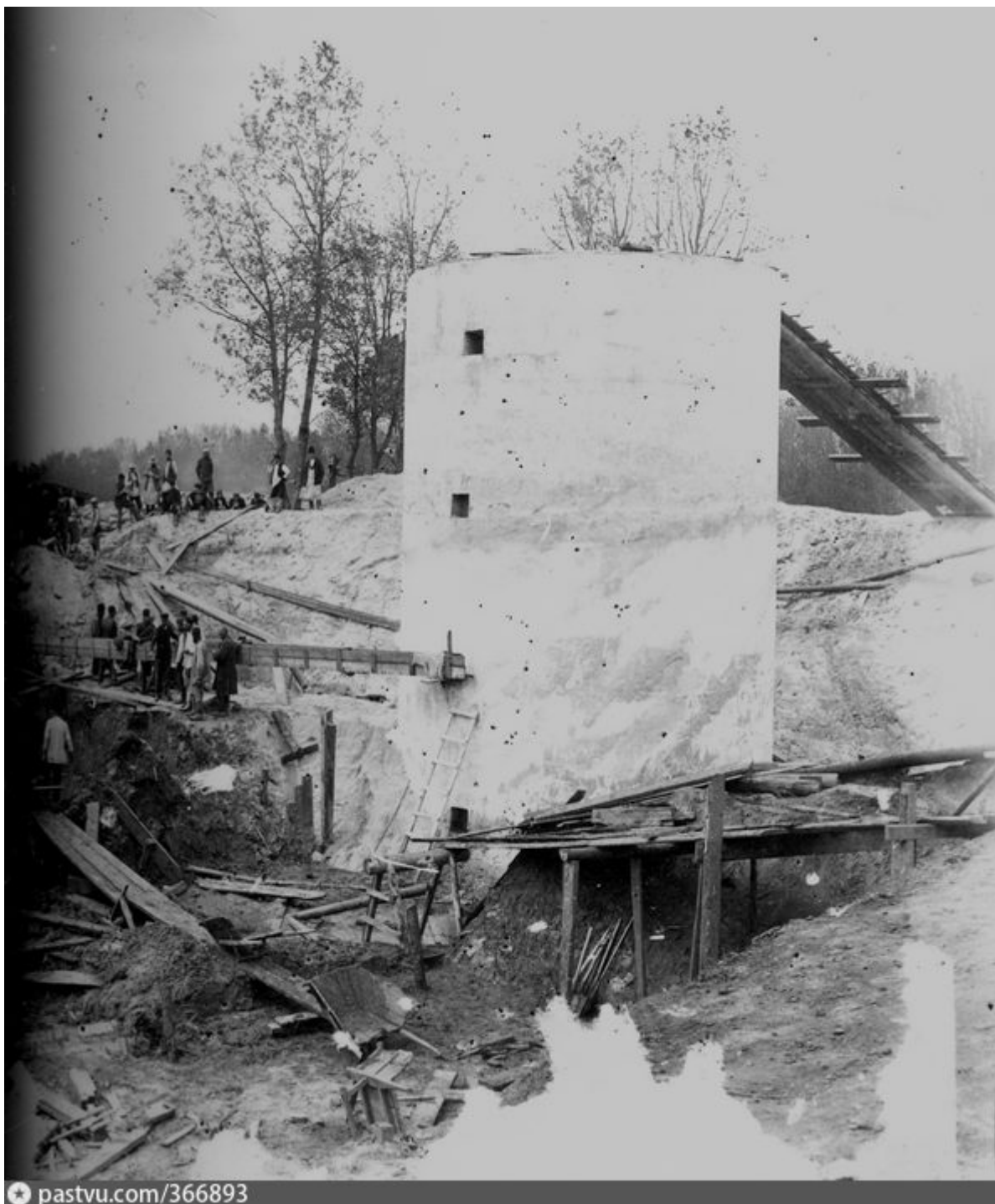
Строительство оголовка водозабора. Фотография, 1914 г.
