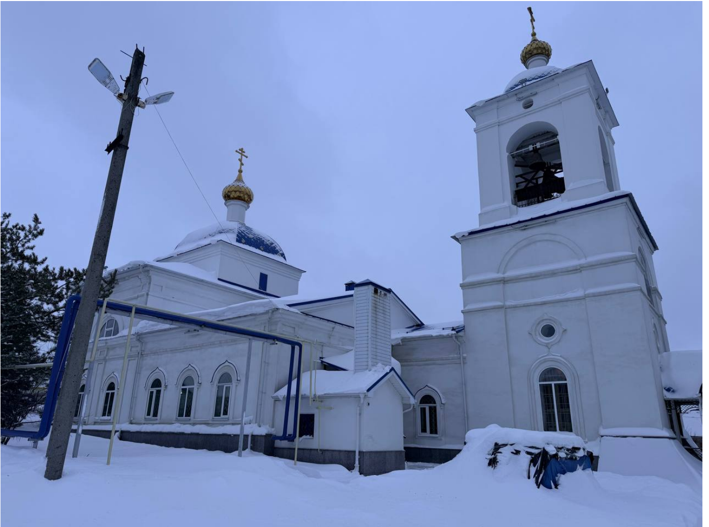
Фото 1. Общий вид с севера
