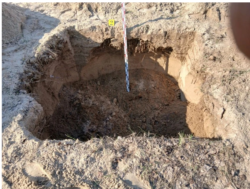
Рис. 10. Шурф №2. Северный борт шурфа после обрушения. Снимок с юга.
