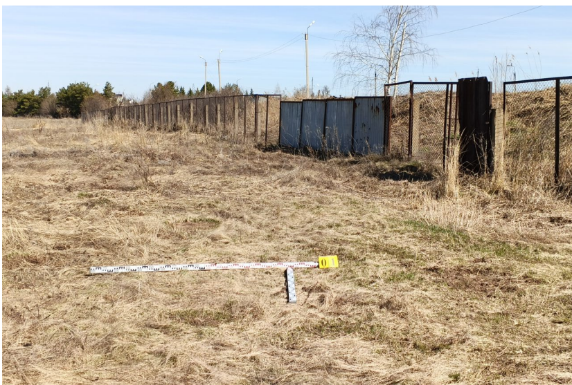
Рис. 9. Шурф №1. Место заложения шурфа. Снимок с юга.
