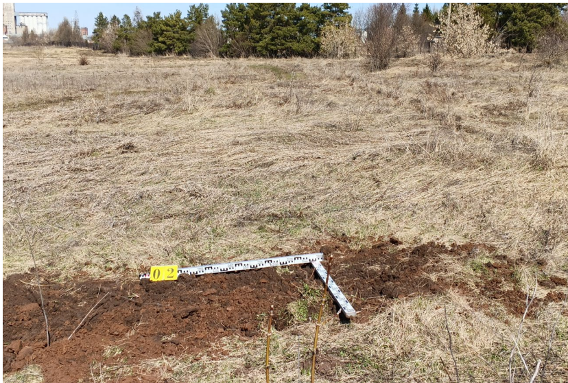
Рис. 16. Шурф №2. Засыпанный шурф. Снимок с юга.
