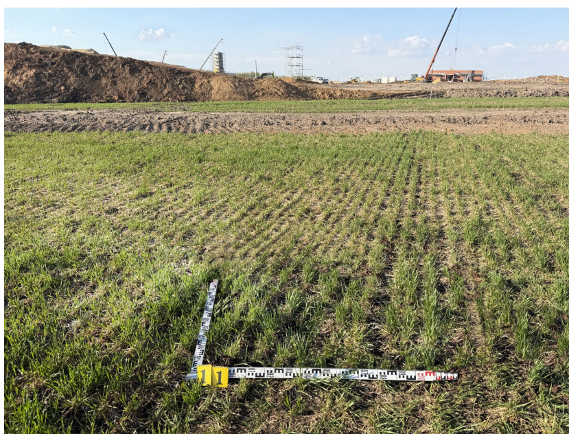
Рис. 45. Шурф №11. Место заложения шурфа. Снимок с юга.
