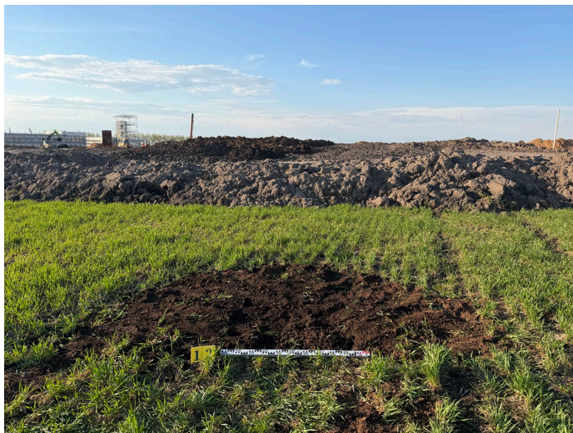
Рис. 52. Шурф №12. Засыпанный шурф. Снимок с юга.
