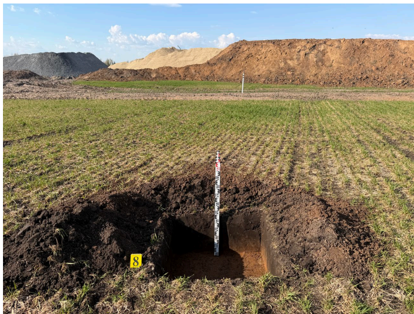
Рис. 34. Шурф №8. Шурф на уровне материка. Снимок с юга.
