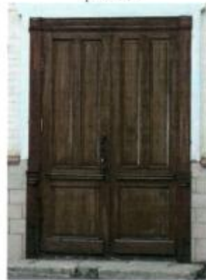
Заполнения дверных проемов главного фасада
