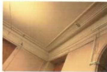
Профилированный карниз и потолочные тяги (гипс)
