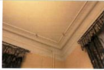
Профилированный карниз и потолочные тяги (гипс)
