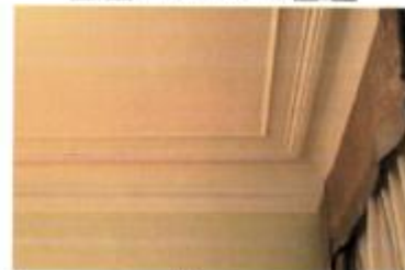
Профилированный карниз и потолочные тяги (гипс)
