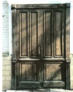
Заполнения дверных проемов главного фасада
