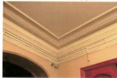
Профилированный карниз и потолочные тяги (гипс)
