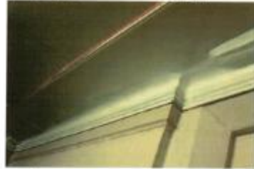
Профилированный карниз (гипс) 2 этаж
