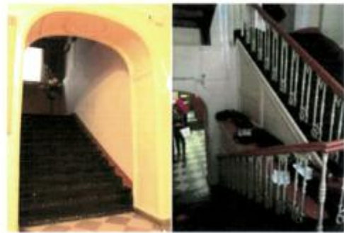
Главная лестница, двухмаршевая П-образная, металлическая с кованым ограждением;
