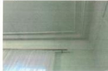
Профилированный карниз и потолочные тяги (гипс)
