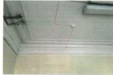
Профилированный карниз и потолочные тяги (гипс)
