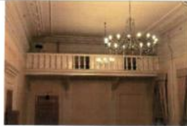
Балкон на кронштейнах, с ограждением
