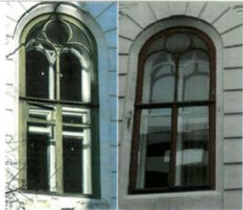
Оконные заполнения боковых фасадов 2 этаж
