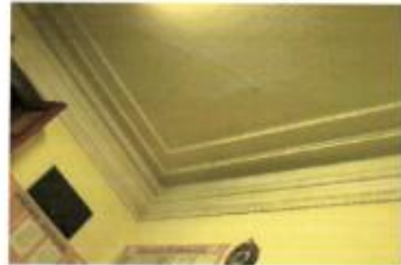
Профилированный карниз и потолочные тяги (гипс)
