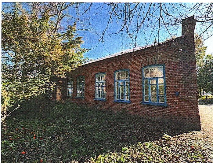
Рис. 8. Фрагмент северо-западного фасада
