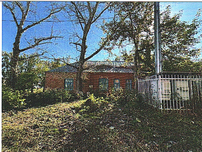
Рис. 7. Фрагмент северо-западного фасада
