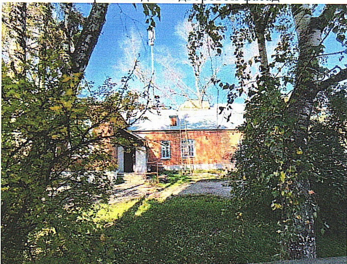
Рис. 21. Вид в северо-западном направлении на северо-восточный дворовой фасад
