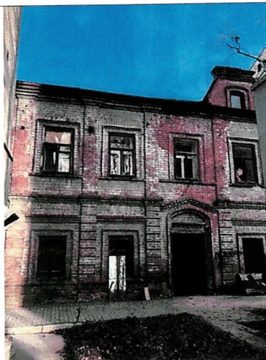
Фрагмент главного фасада
