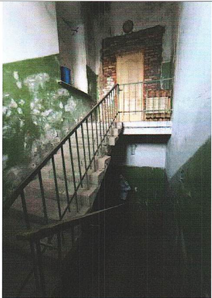
Рис.15. Лестница в подвал
