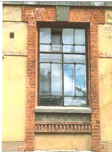
Заполнение оконных проемов
