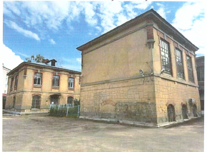
Общий вид дворового фасада
