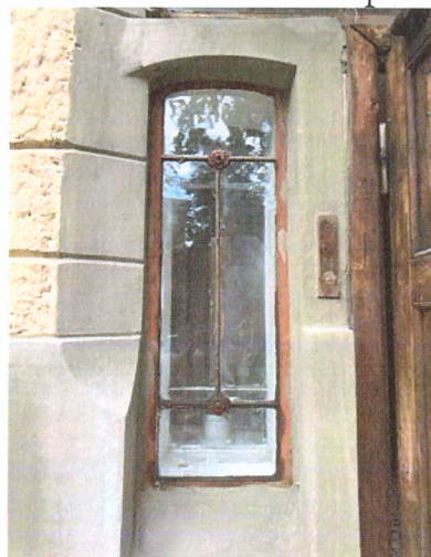
Заполнение оконных проемов
