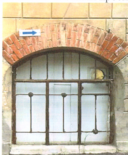
Заполнение оконных проемов
