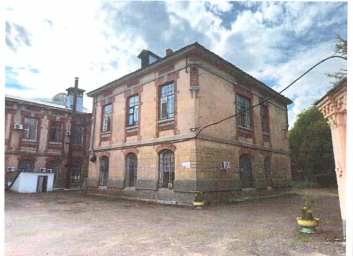
Общий вид дворового фасада
