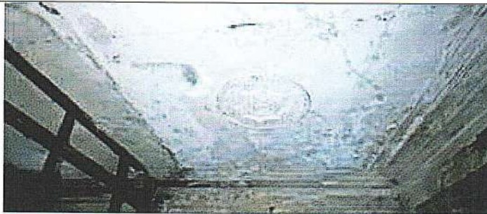
Рис.11-12. Розетка на потолке помещения второго этажа
