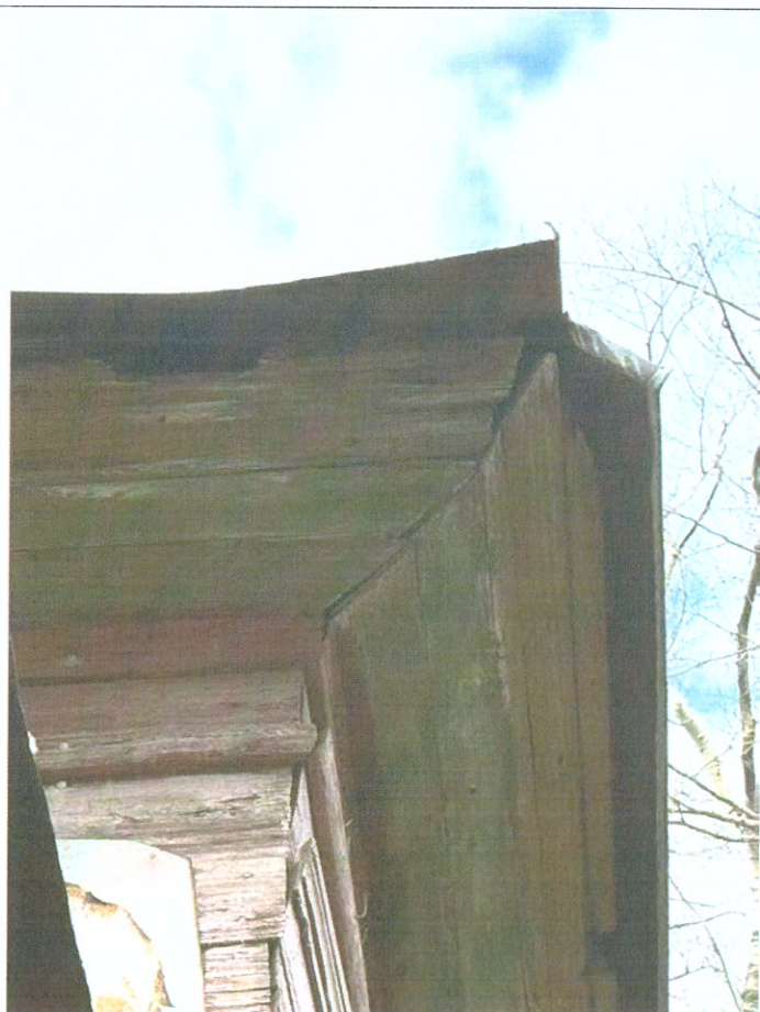
Ступенчатый профилированный карниз большого выноса, двухрядный плоский фриз из обшивочных досок
