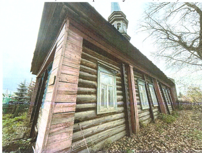
Общий вид западного фасада (обшитые тесом пилястры по углам дома и по длине здания (в месте примыкания внутренних поперечных стен сруба))
