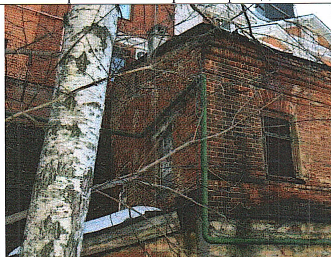
Фрагмент восточного фасада здания.
