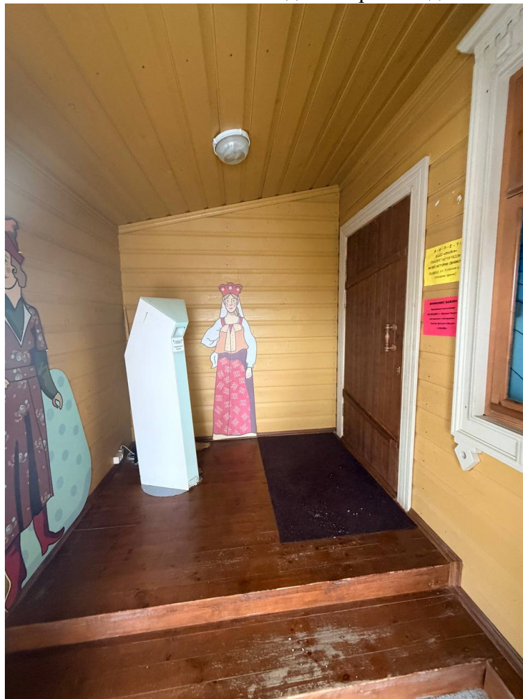
Фото 6. Вид с северо-запада. Пристроенный тамбур
