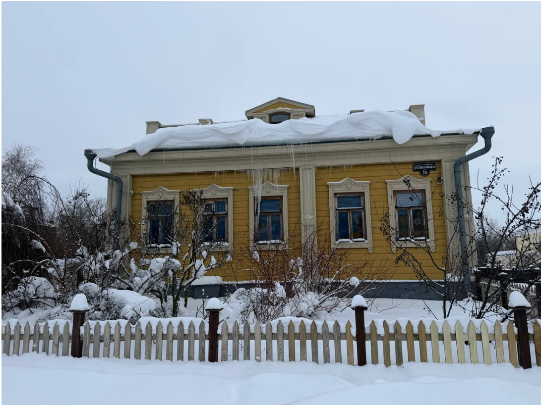
Фото 5. Вид с северо-запада
