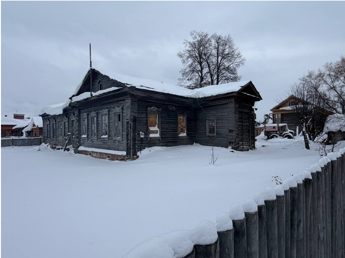
Фото 1. Общий вид с запада
