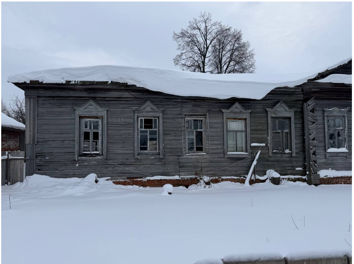
Фото 4. Вид с северо-запада
