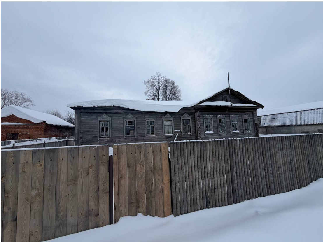
Фото 2. Вид с северо-запада
