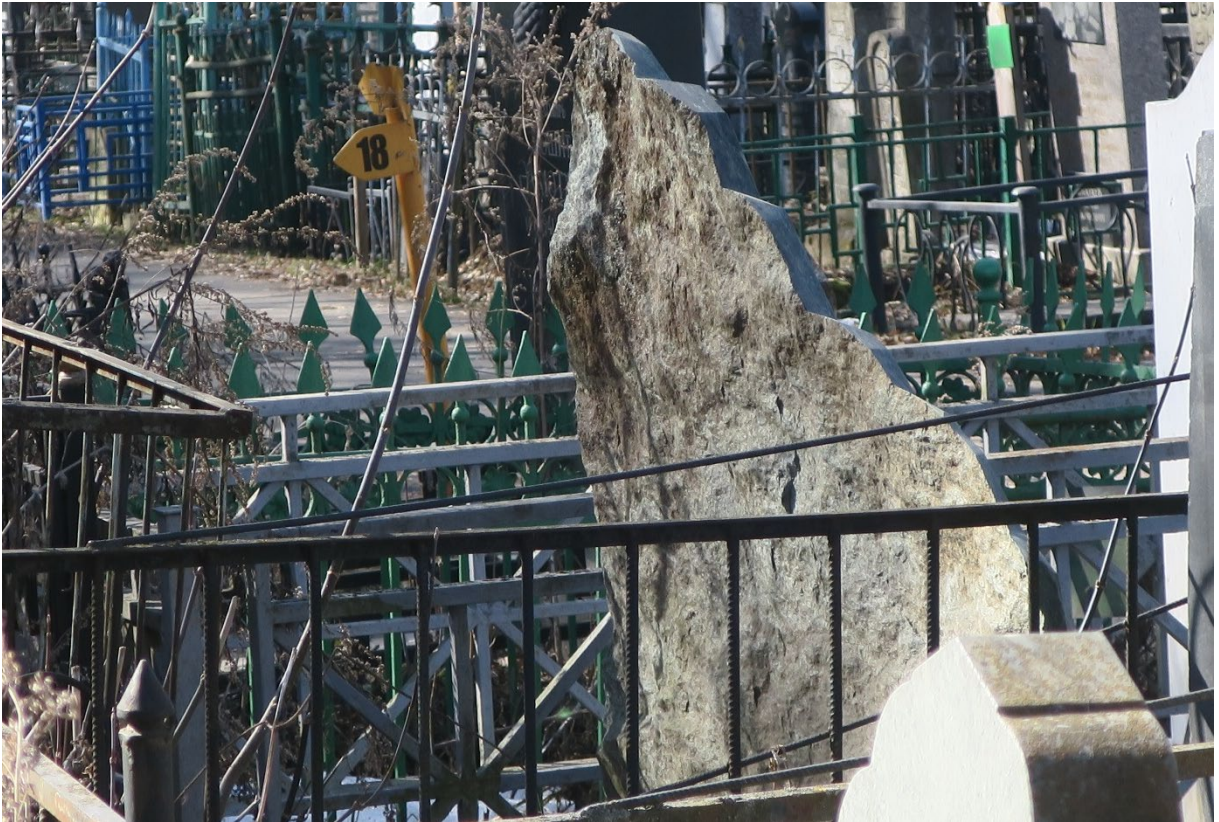
Фото 3. Тылная сторона вертикальной плиты
