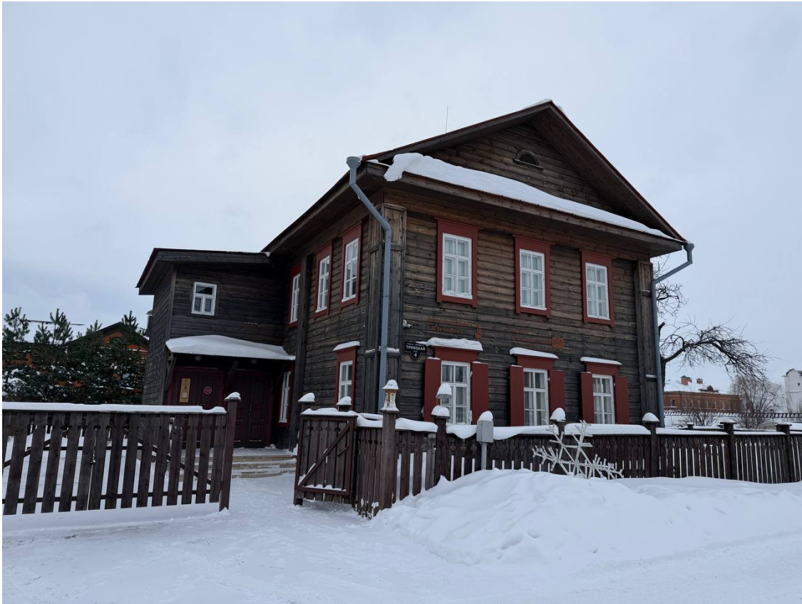
Фото 1. Общий вид с северо-запада
