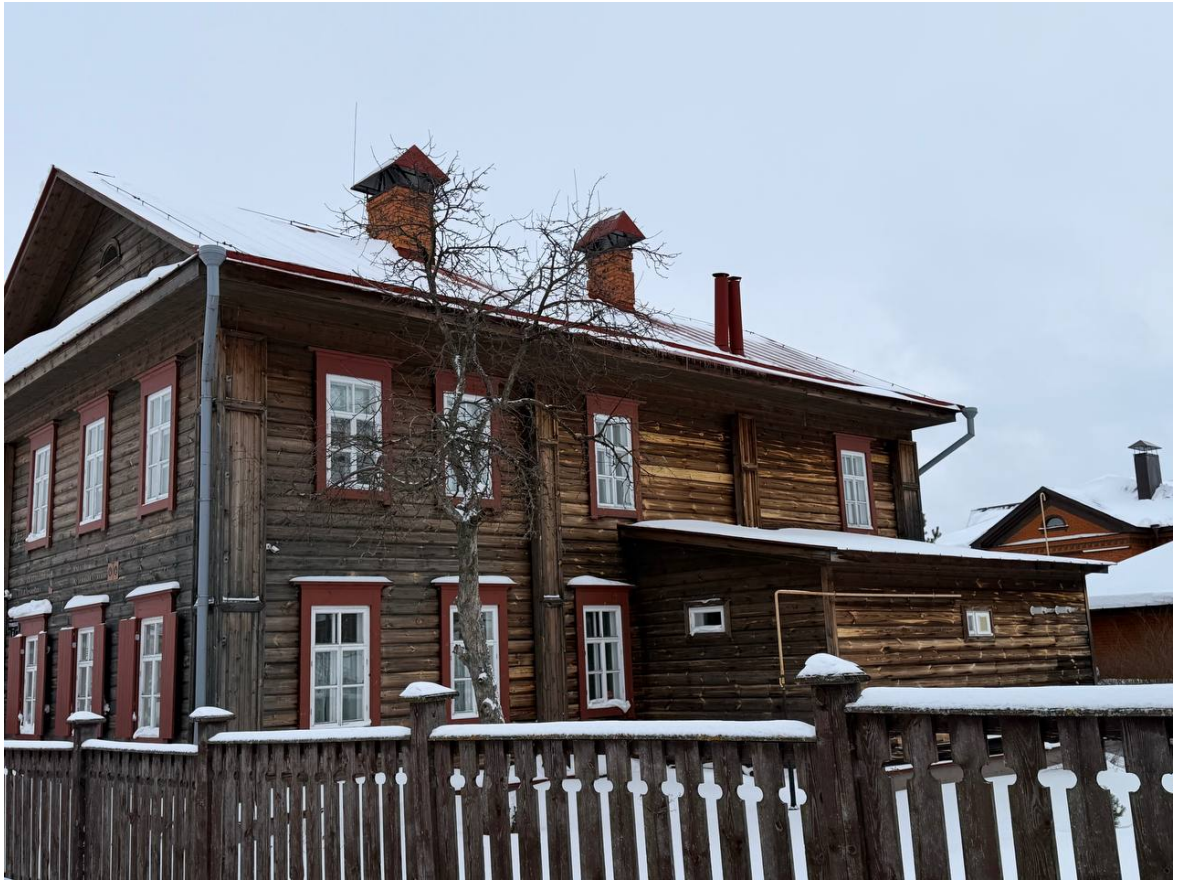
Фото 3. Вид с юга
