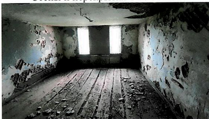
Стены и перекрытия мезонина.
