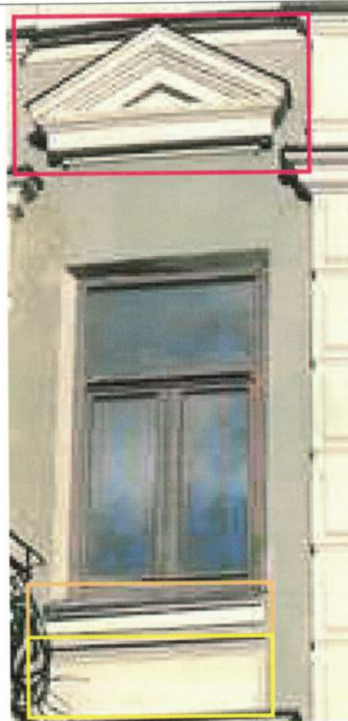
Сандрик Тяга Панно Оконный проем 3 этажа на пересечении ул. Баумана и Чернышевского.
