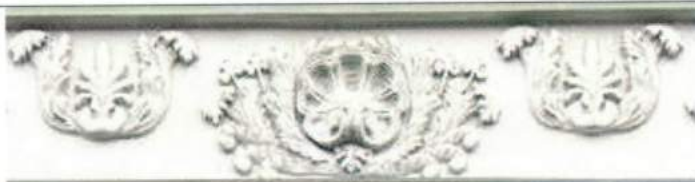
Лепной декор на главном фасаде по ул. Баумана.
