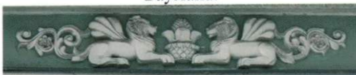
Декоративное заполнение на главном фасаде по ул. Баумана.
