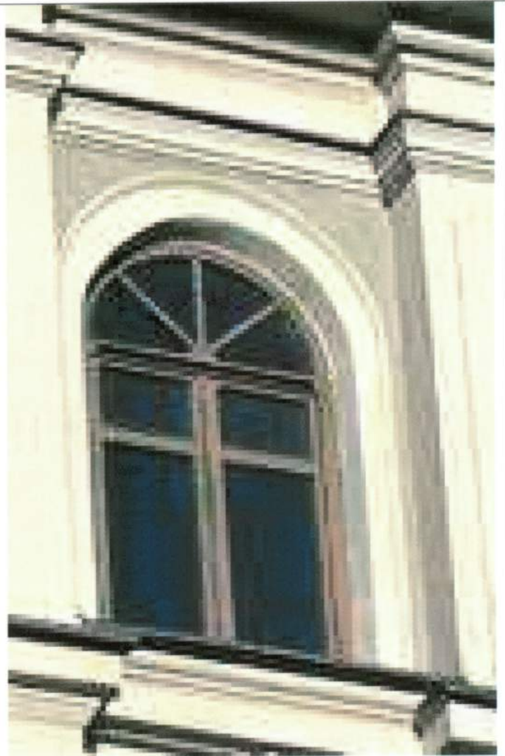
Оконный проем 4 этажа на ул. Чернышевского.
