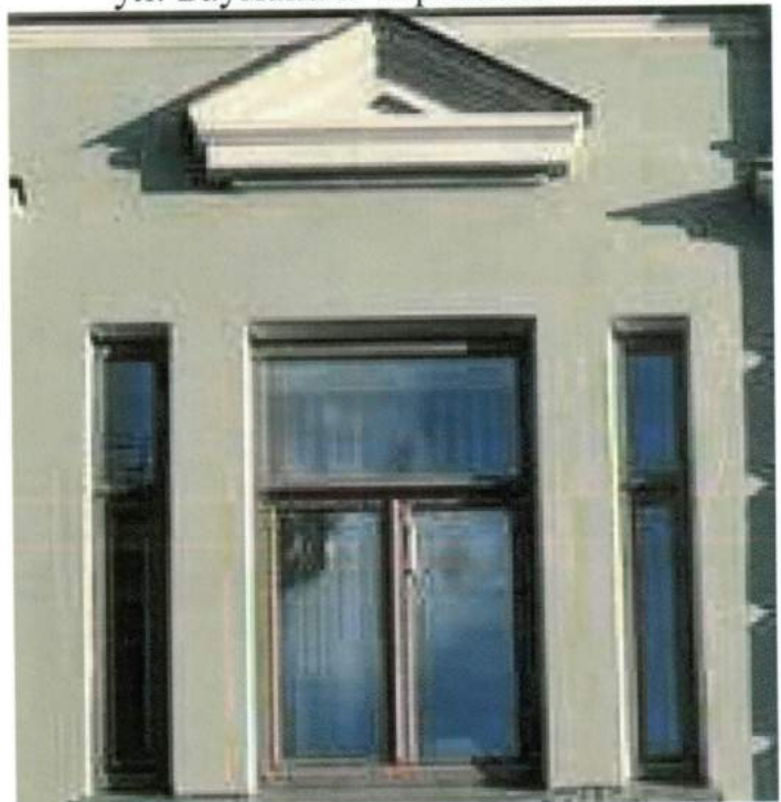
Оконный проем 3 этажа на ул. Чернышевского.
