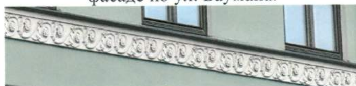
Подоконное декоративное заполнение на главном фасаде по ул. Баумана.
