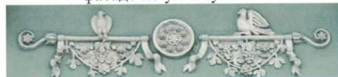
Декоративное заполнение на главном фасаде по ул. Баумана.
