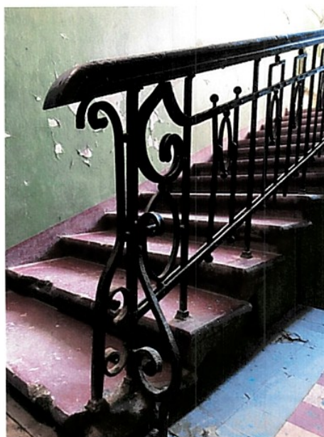
Поручень и ограждение лестницы в осях 5-6
