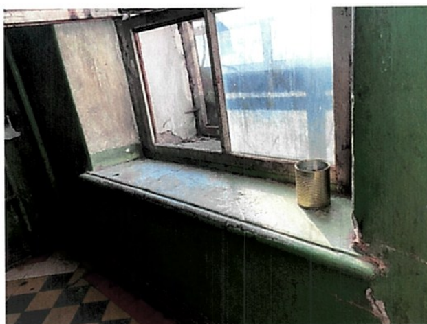
Подоконная плита с валиком окна лестничной площадки в осях 5-6
