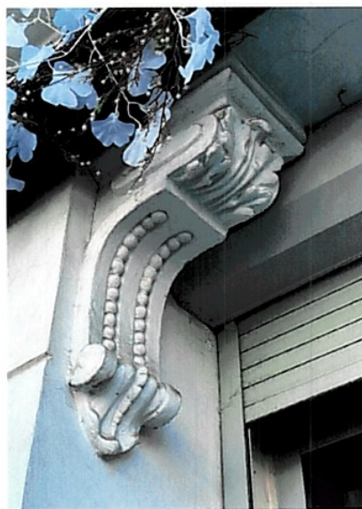
Лепной кронштейн во входной группе главного фасада. Современное фото.
