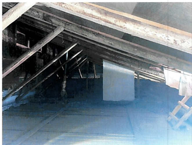
Фото чердачного помещения в осях Е-И
