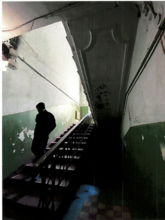
Историческая лестница в осях 5-6
