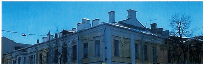
Современное фото кровли.
