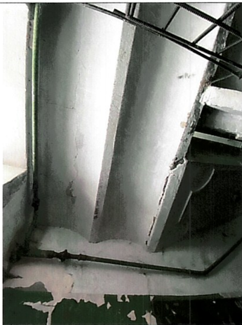
Своды Монье в осях 5-6
