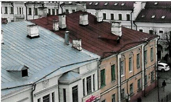
Фото кровли. 2010 год. Р. Ахунов.
