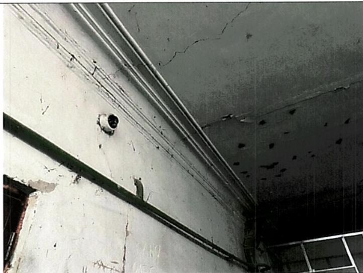
Потолочные тяги первого этажа в осях 5-6
