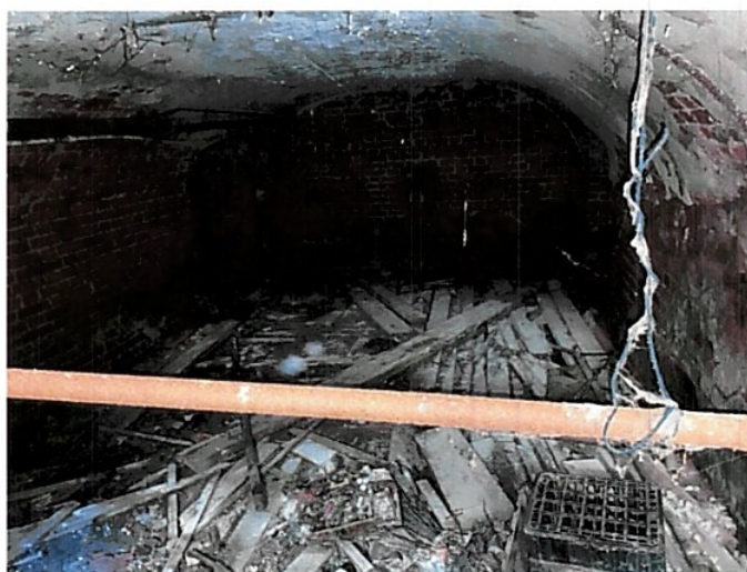
Фото подвала между осями 4-5
