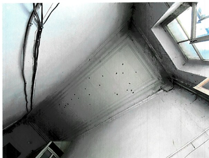
Потолочные тяги второго этажа в осях 5-6
