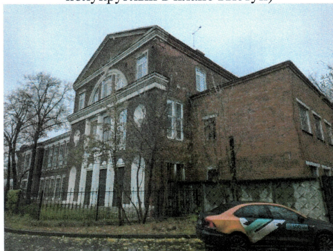
Рис.30. Общий вид бокового (западного) фасада. Местоположение оконных проемов
