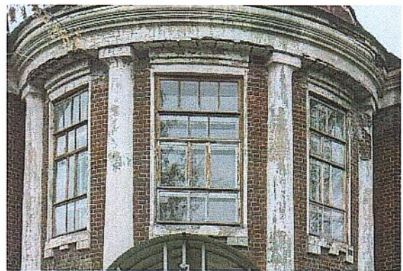
Рис.19-21. Оформление оконных проемов второго этажа и венчающего карниза
