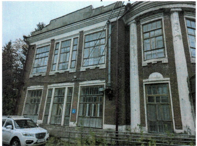
Рис.24. Общий вид, оформление бокового (восточного) фасада
