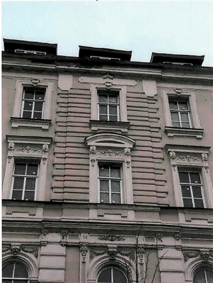
Оконные проемы 3-4 этажей
