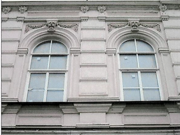
Оконные проемы 2 этажа
