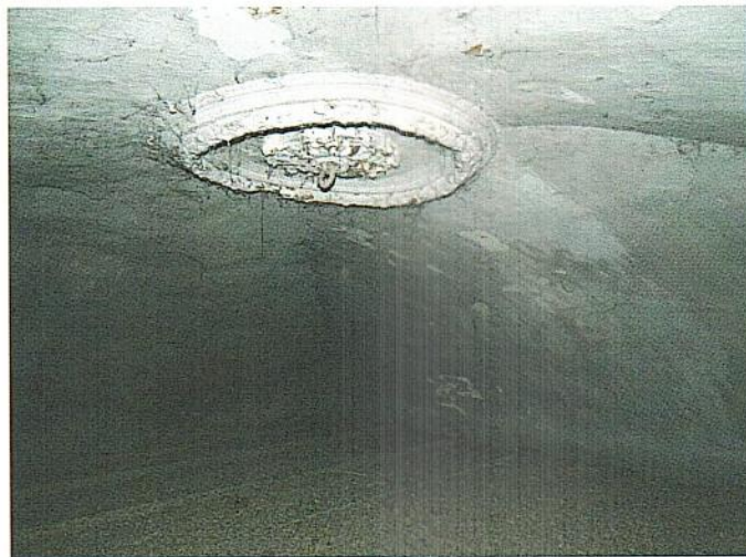
Розетка на своде 2-го яруса
