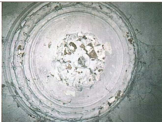
Розетка на своде 2-го яруса
