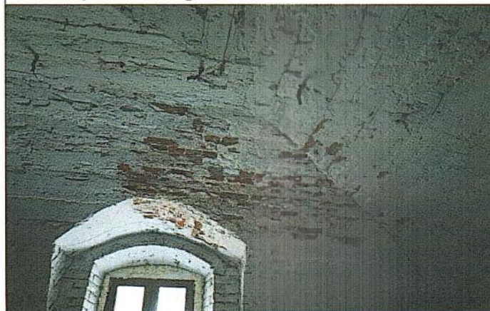
Распалубки над проемами
