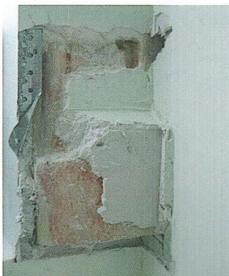
Исторические наличники оконных проемов
