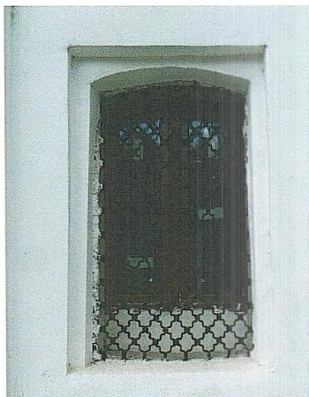
Подлинные оконные решетки
