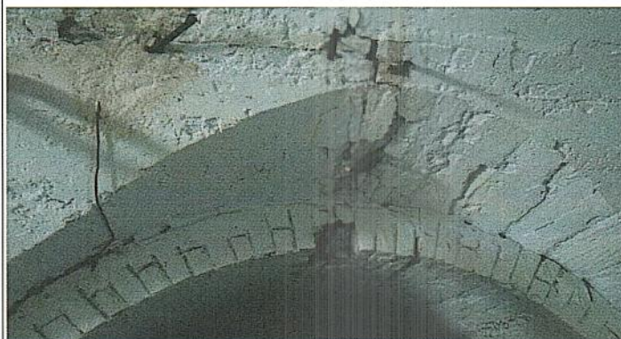
Распалубки над проемами
