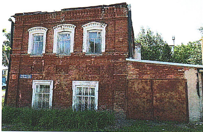
Рис. 3. Вид на здание при движении по ул. Ленина с севера (точка 1)
