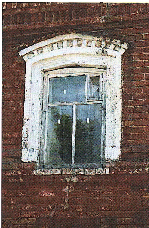
Рис. 19. Широкие рамочные наличники оконных проемов второго этажа с завершением сандриками с сухариками и покрытием из металлического листа с просечкой
