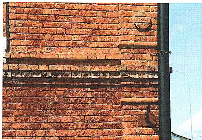
Рис. 13. Подоконный ступенчатый карниз оконных проемов второго этажа
