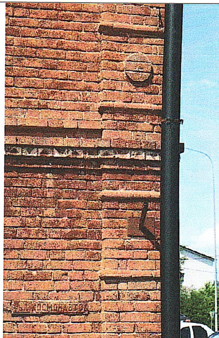
Рис. 15. Лопатки с валиками в каждом восьмом ряду кладки и круглыми розетками без декора
