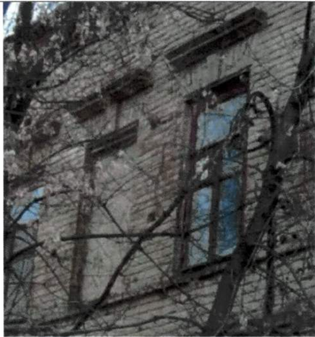
Рис. 22. Высокие прямоугольные оконные проемы второго этажа с сандриками в виде прямого профилированного карниза и замковыми камнями
