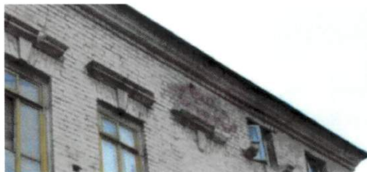
Рис. 15. Профилированный венчающий карниз
