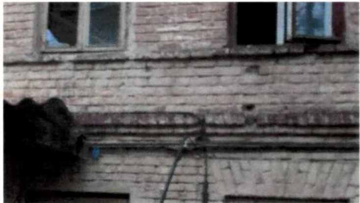
Рис. 23. Профилированный междуэтажный пояс; пояс простого профиля, проходящий в уровне подоконника под оконными проемами второго этажа
