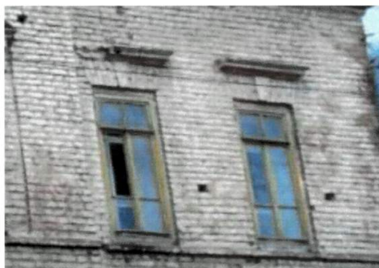
Рис. 8. Оконные проемы 2-го этажа в левой и правой частях фасада – с сандриками в виде прямого профилированного карниза и замковыми камнями
