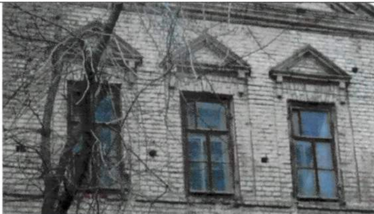
Рис. 7. Оконные проемы 2-го этажа центральной части фасада с треугольными профилированными сандриками на кронштейнах и замковыми камнями
