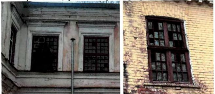
Сохранившиеся столярные заполнения.
