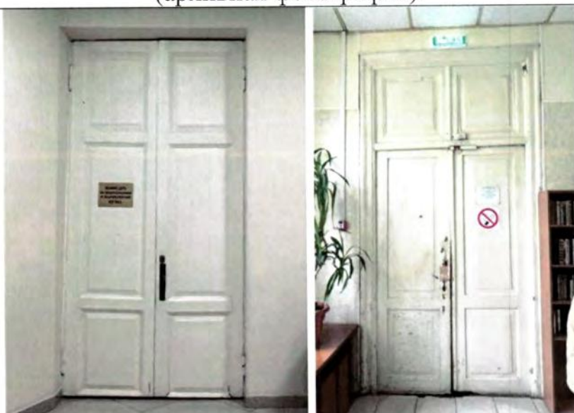
Двустворчатые деревянные филенчатые двери
