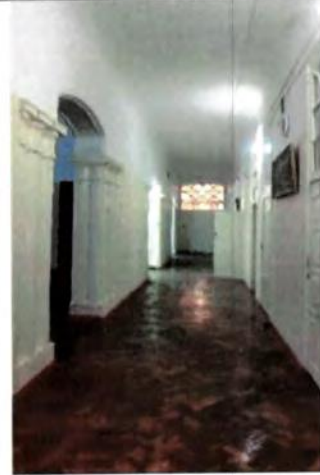
Арочные порталы на колонках, собранные в пучки.
