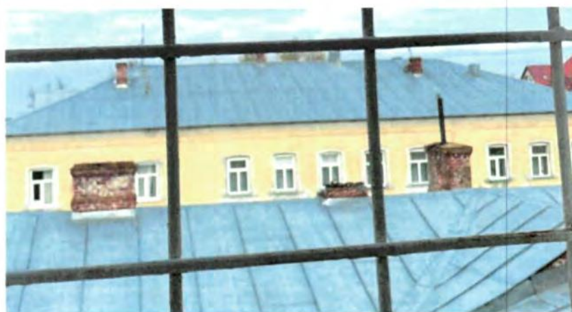
Печные трубы в пристроях.
