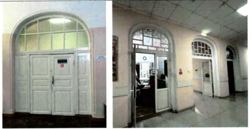
Оформление порталов остекленными фрамугами с оригинальной расстекловкой.
