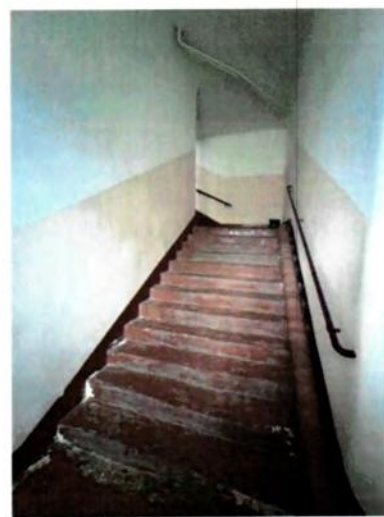
Лестницы на кирпичных сводах со ступенями из композитного материала.
