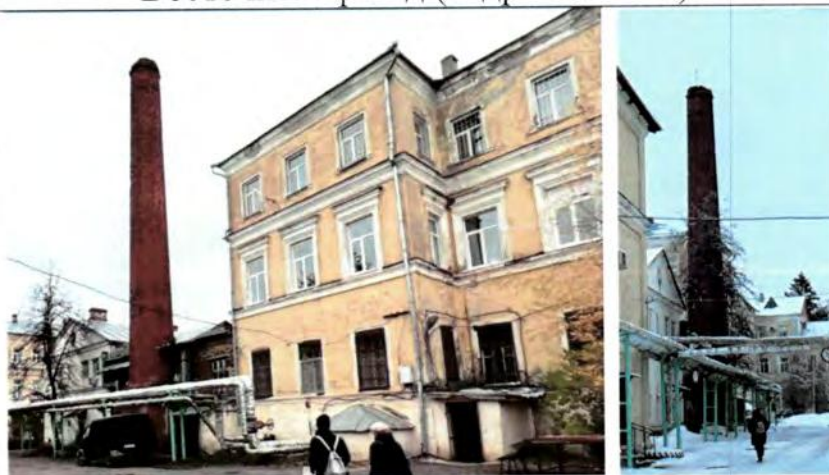
Фасады красно-кирпичной трубы.
