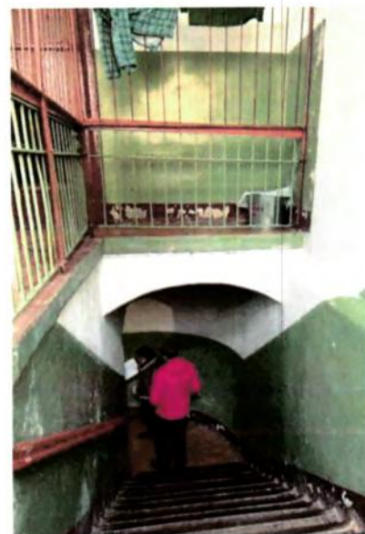
Лестницы с каменными профилированными ступенями (частично утрачены).
