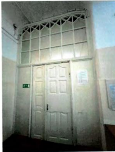
Оформление порталов остекленными фрамугами с оригинальной расстекловкой.
