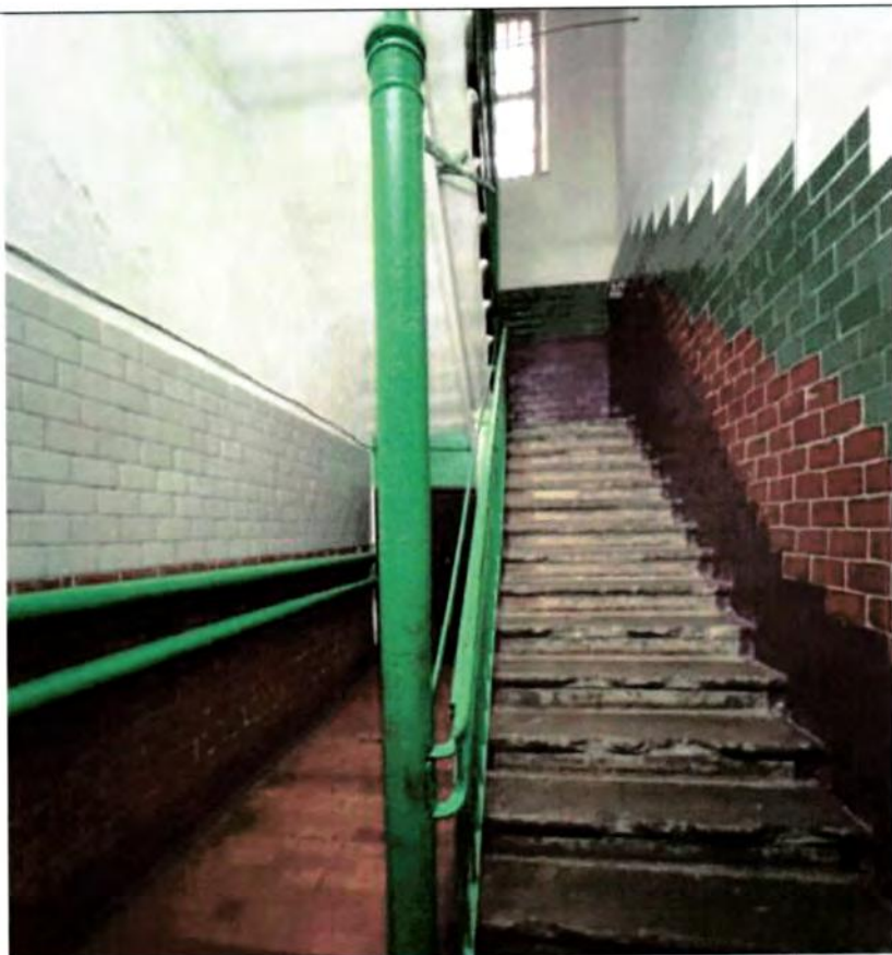
Лестницы на косоурах со ступенями из натурального камня/композитного материала.
