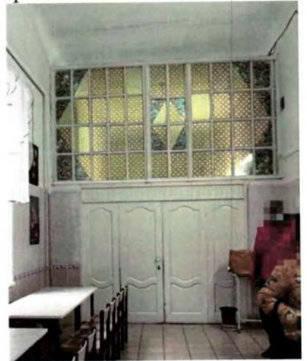
Оформление порталов остекленными фрамугами с оригинальной расстекловкой.
