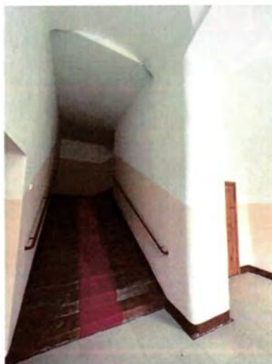
Лестницы на кирпичных сводах со ступенями из композитного материала.
