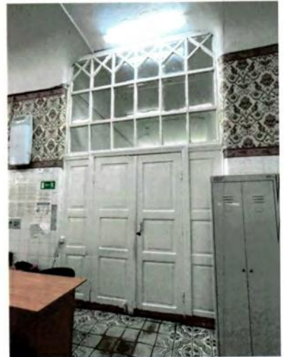
Оформление порталов остекленными фрамугами с оригинальной расстекловкой.
