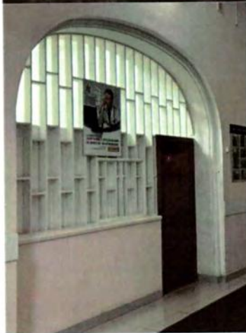
Арочные проемы, оформленные штукатурным валиком.
