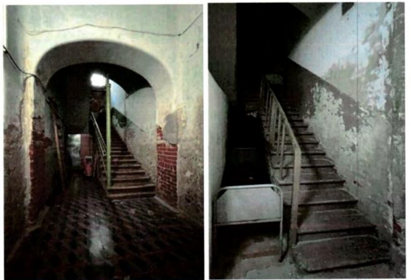
Лестницы с каменными профилированными ступенями (частично утрачены).
