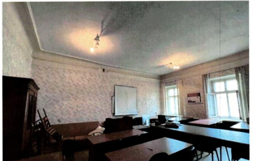
Потолочные штукатурные тяги по периметру помещений.
