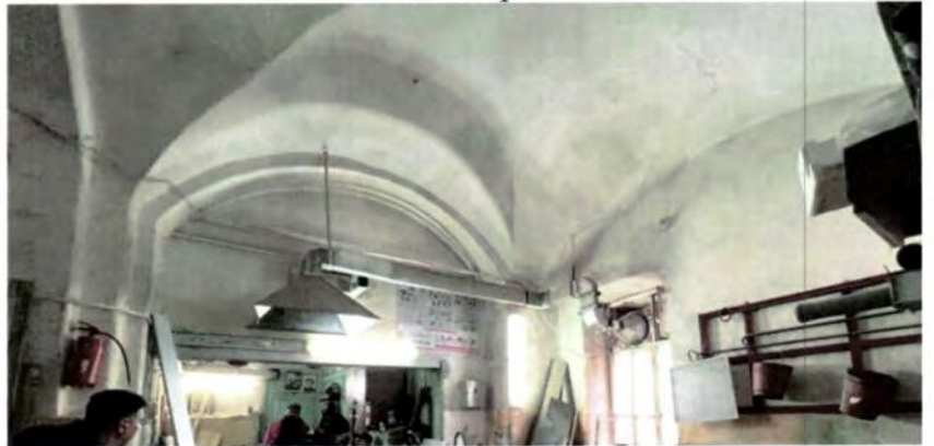
Кирпичные своды первого этажа.
