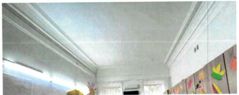
Потолочные штукатурные тяги по периметру помещений.
