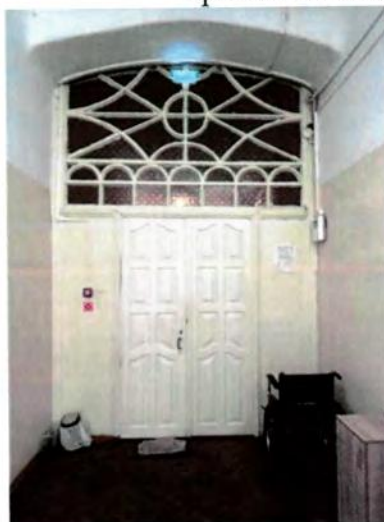
Оформление порталов остекленными фрамугами с оригинальной расстекловкой.
