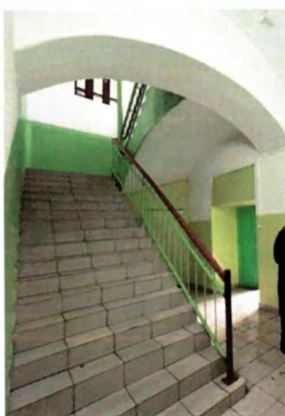
Лестницы с каменными профилированными ступенями (частично утрачены).
