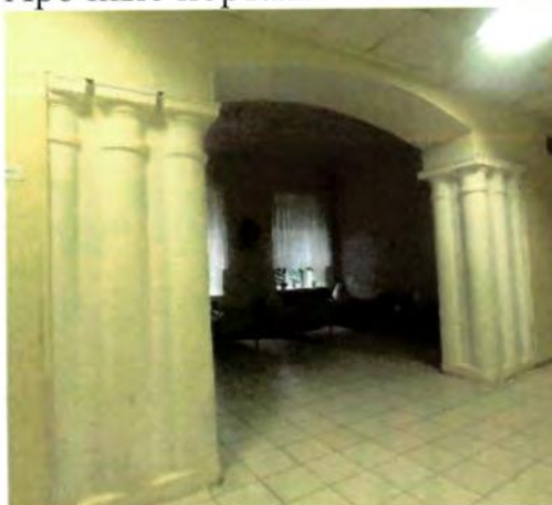
Арочные порталы на колонках, собранные в пучки.
