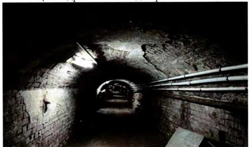
Цилиндрический свод подвала.
