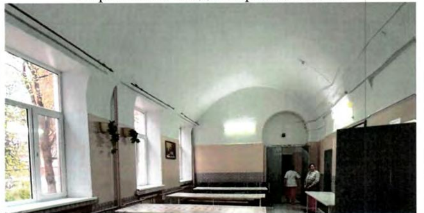
Цилиндрический свод первого этажа.
