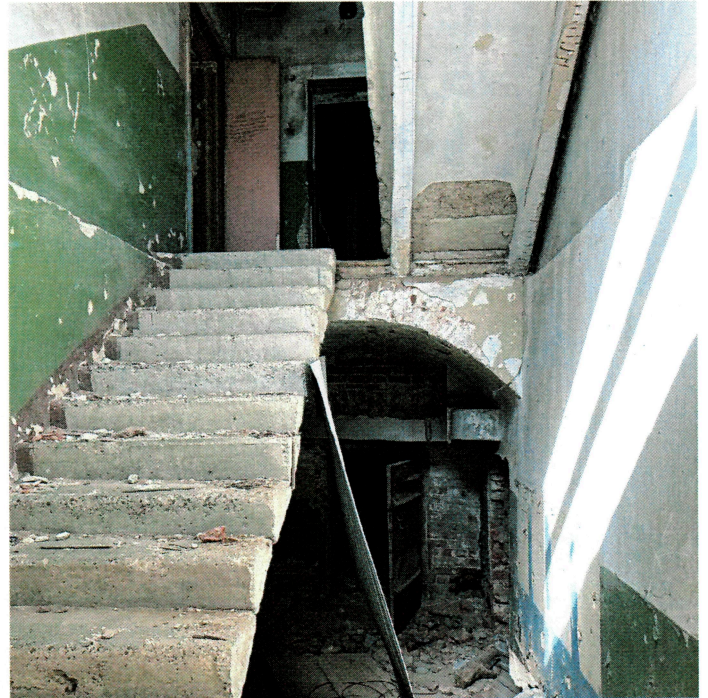
Лестничная клетка 1-го этажа.
