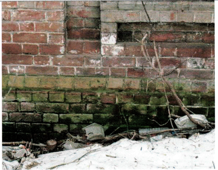
Выступающий от плоскости стены кирпичный цоколь.
