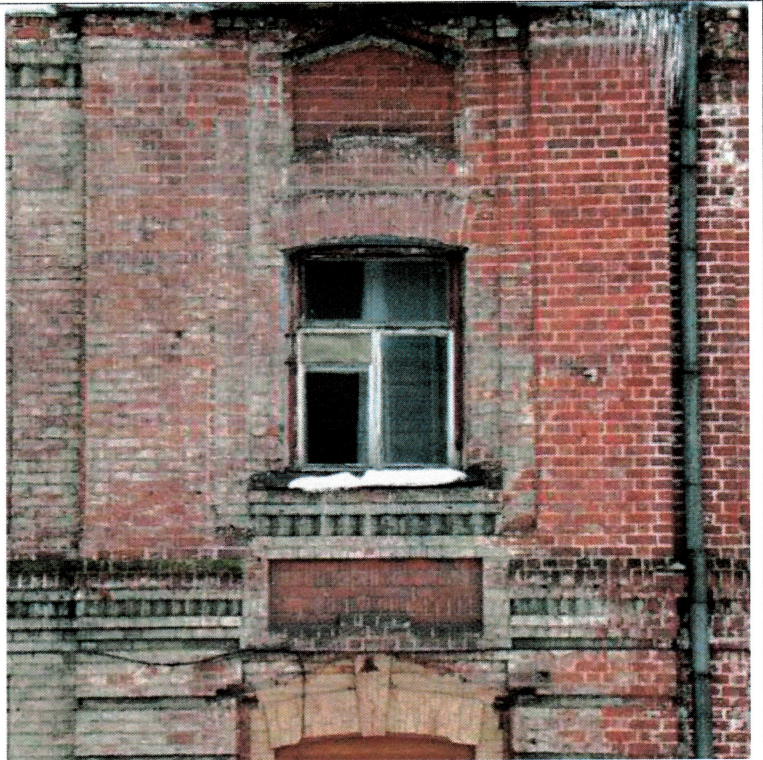
Ниши ризалита по северному фасаду.
