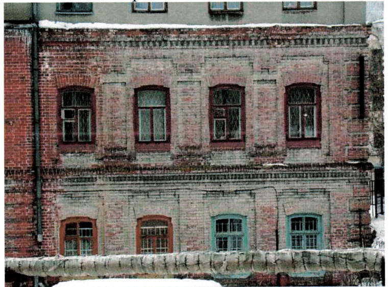
Лучковые перемычки исторических окон.
