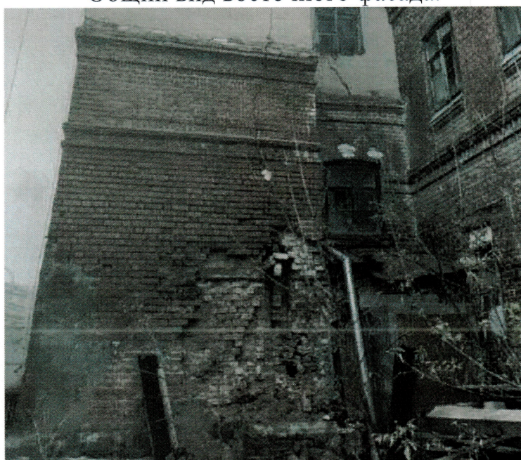
Общий вид восточного фасада пристроя.
