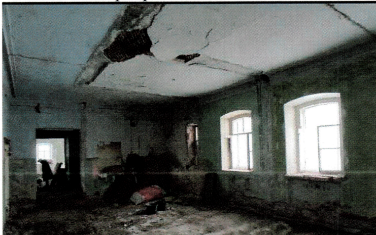
Плоские перекрытия между 1 и 2 этажами.
