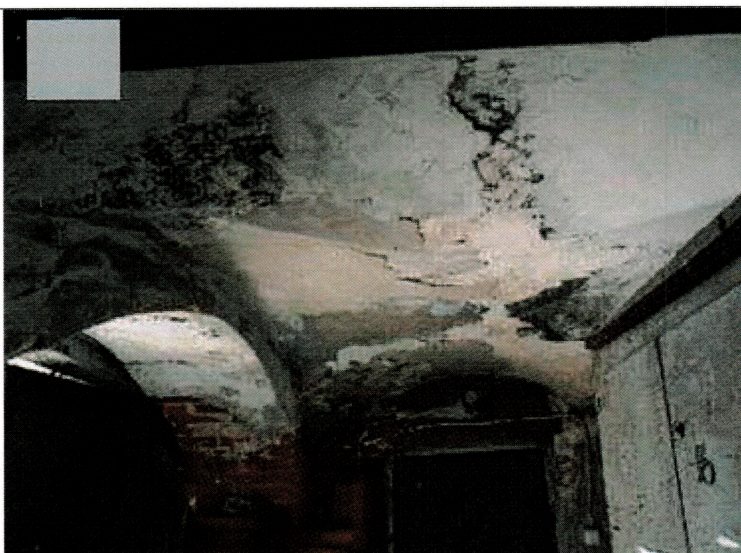
Сводчатые перекрытия помещений №7 и №9.
