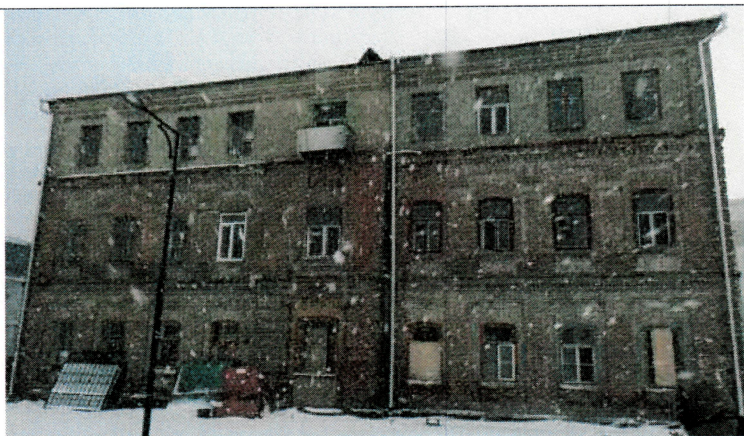
Общий вид главного (северного) фасада.
