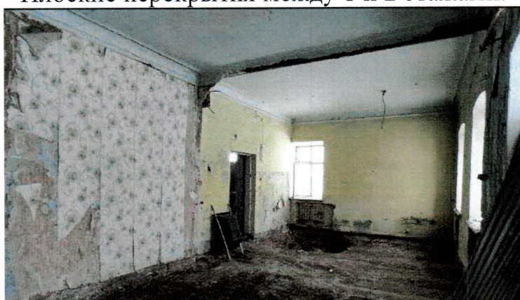
Плоские перекрытия между 1 и 2 этажами.
