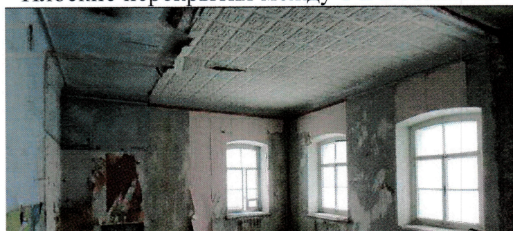
Плоские перекрытия 2 этажа.
