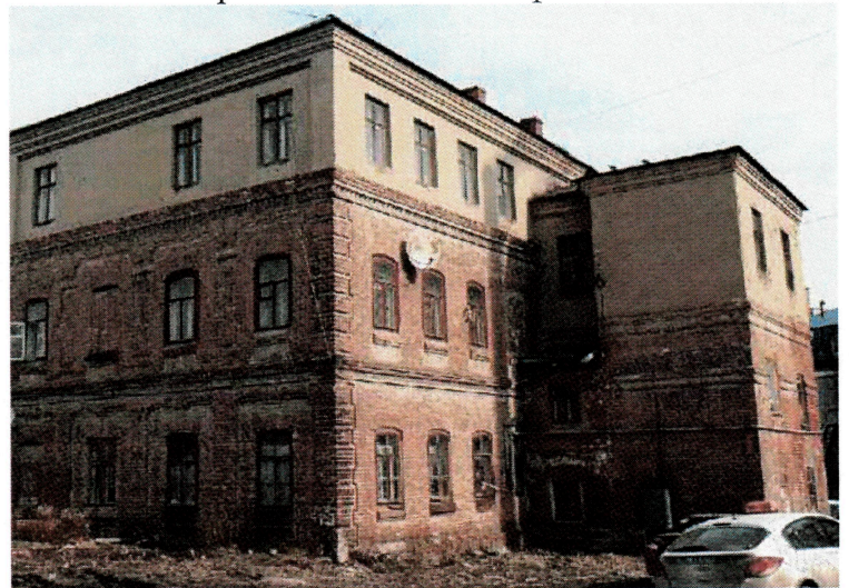
Фрагмент южного фасада.
