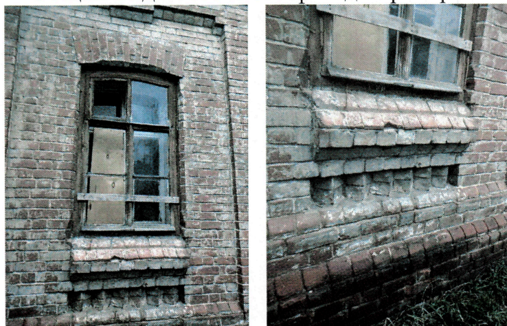
Фрагменты восточного фасада.
