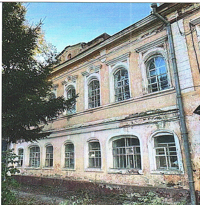
Рис. 6. Левая от входа часть фасада по ул. Октябрьской
