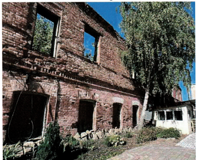
Рис.8. Вид в северном направлении на боковой фасад
