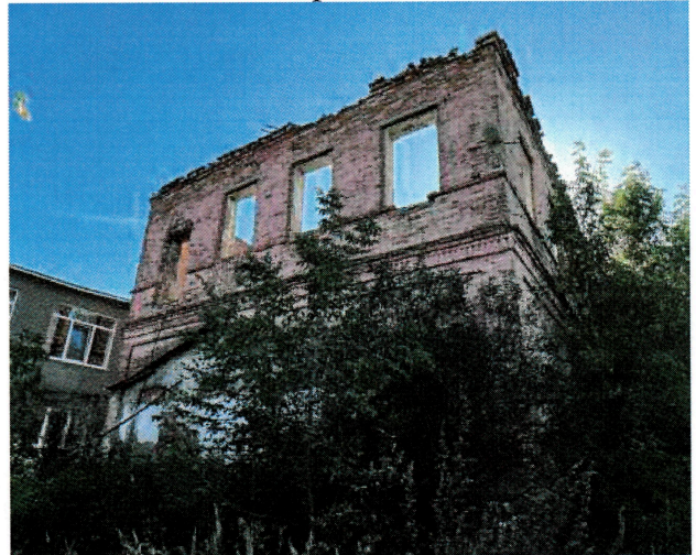
Рис.11. Вид в южном направлении на дворový фасад
