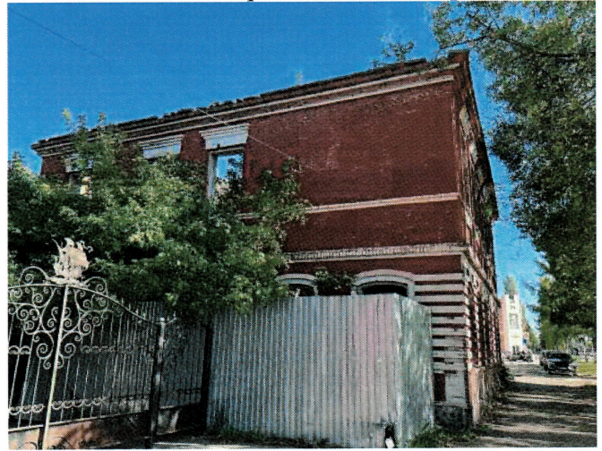
Рис.10. Вид в восточном направлении на боковой фасад
