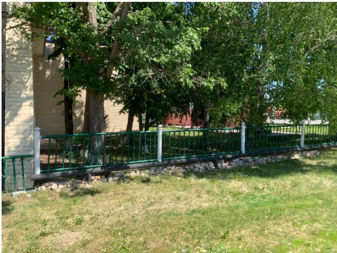
Фото 3. Вид с северо-востока
