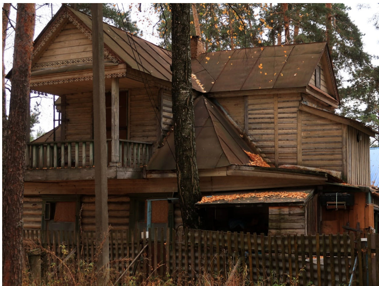
Фото 4. Вид с северо-запада
