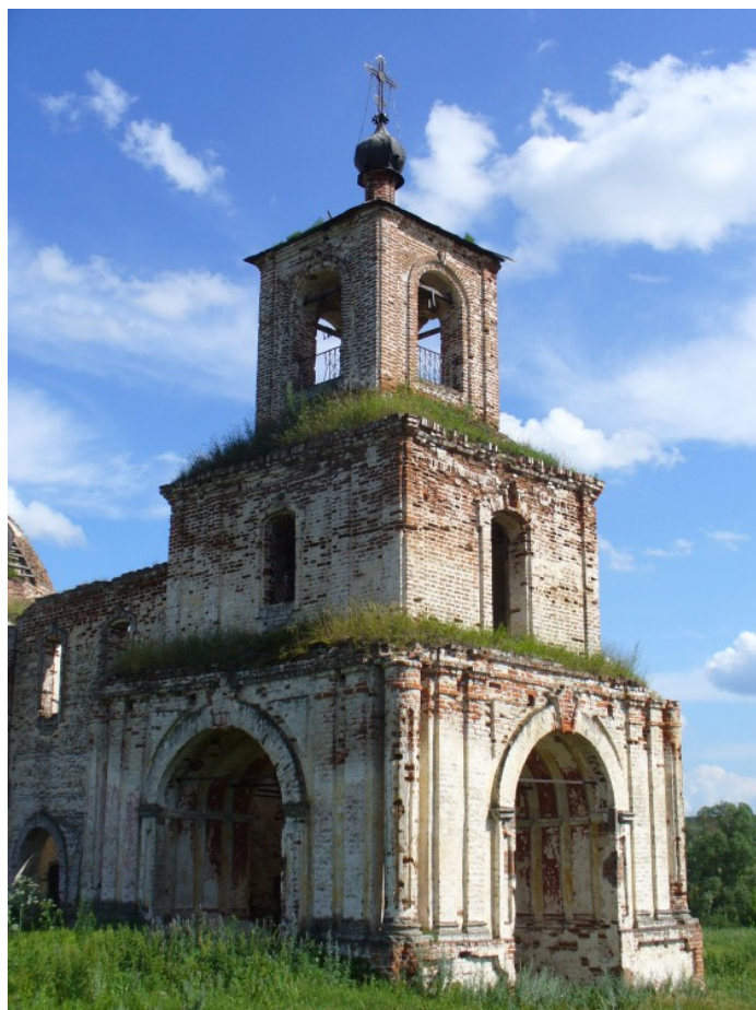
Фото 4. Вид с северо-запада
