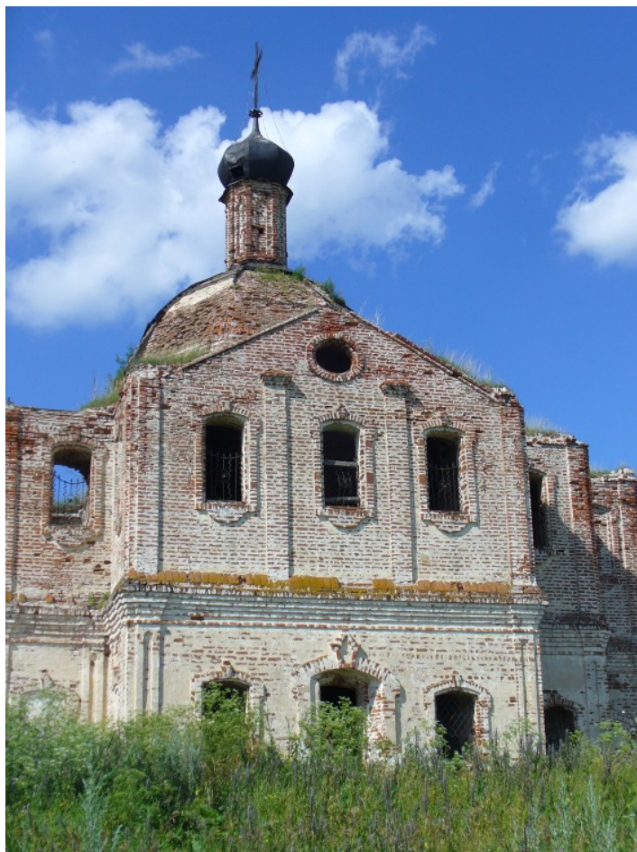
Фото 3. Вид с юга
