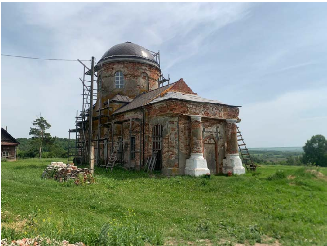
Фото 3. Вид с северо-запада
