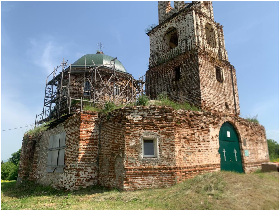
Фото 3. Вид с северо-запада
