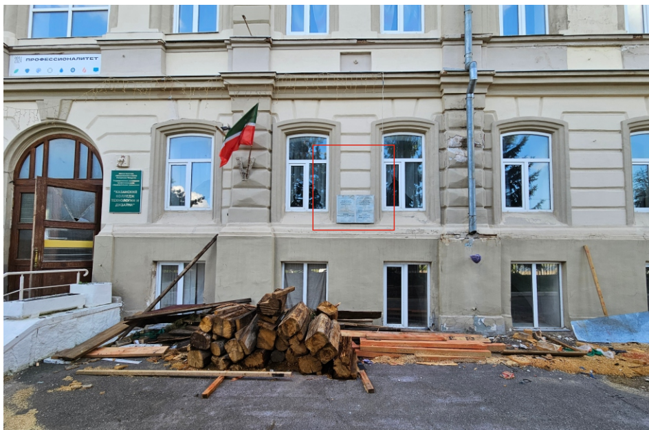
Вид на объект до установки информационной надписи
