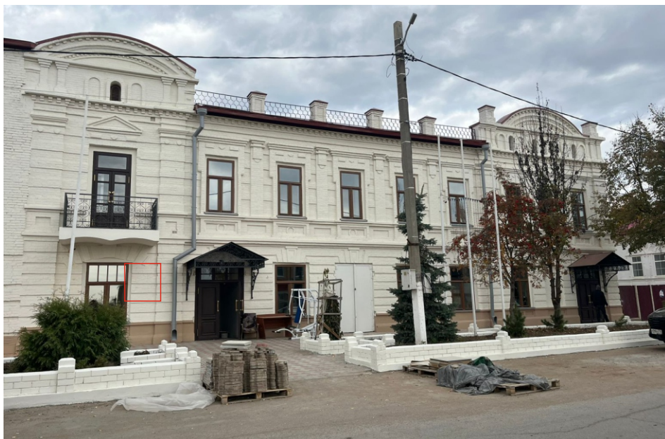
Вид на объект до установки информационной надписи
