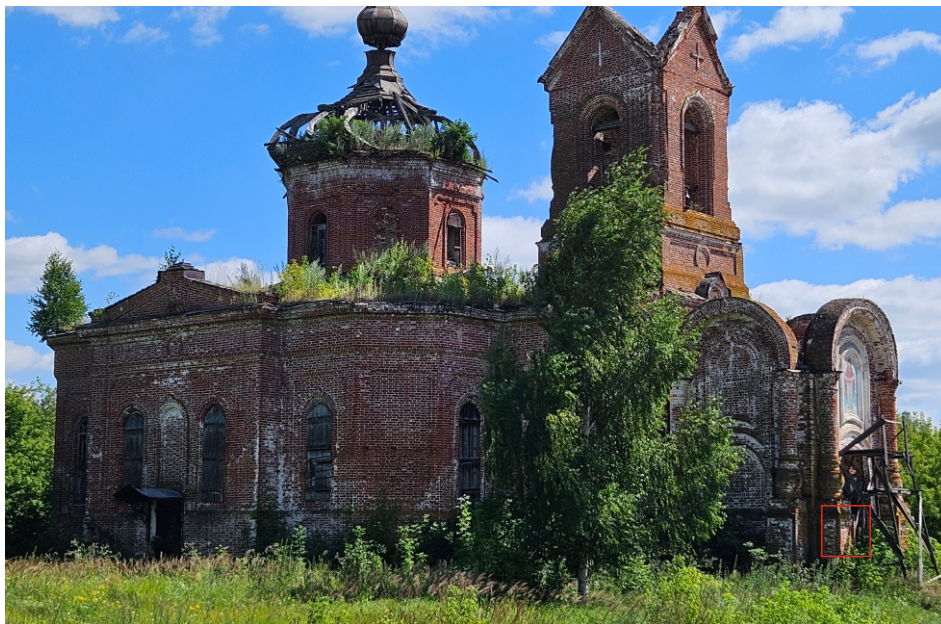
Вид на объект до установки информационной надписи
