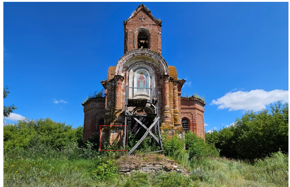
Вид на объект до установки информационной надписи
